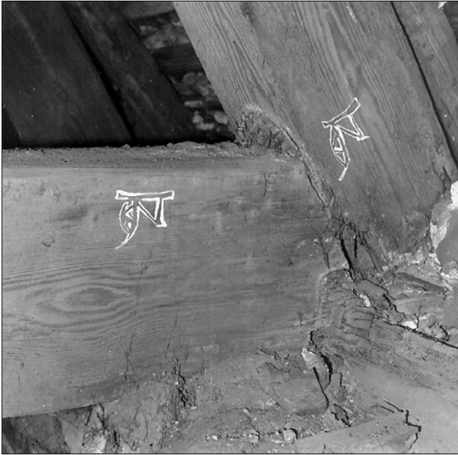
Obr. 13: Krov nad presbytářem, stávající 14. vazba, jižní strana. Příklad dochované tesařské značky původního gotického krovu v místě tesařského spoje vazného trámu a krokve (zvýrazněno).
