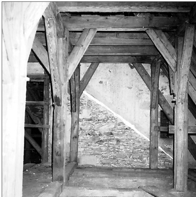
Obr. 19: Profil původního zastřešení boční lodě, zachovaný v otisku omítky na západní straně věže.
