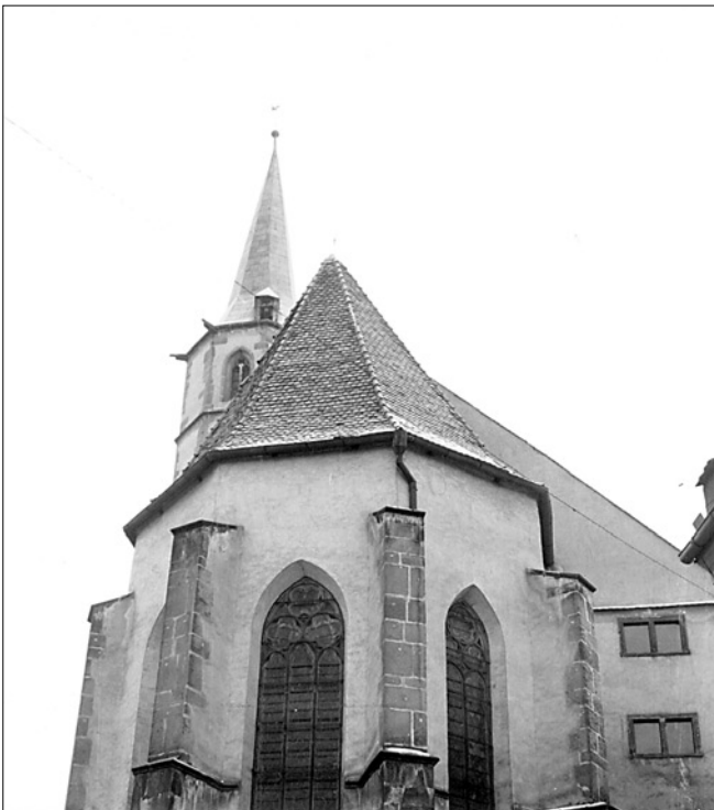
Obr. 16: Západní pohled na presbytář kostela. Výška pultového zakončení opěrných pilířů odpovídá výšce koruny obvodového zdiva před požárem (viz. též pol. u na obr. 10).
