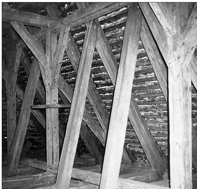
Obr. 7: Úsek krovu nad presbytářem mezi jeho stávající 15. - 19. vazbou, jižní strana. Záběr na zachované šikmé pateční stojky ve stávajících mezilehlých vazbách. V dodatečně vytvořených plných vazbách musely být tyto stojky odstraněny, neboť by bránily osazení nové zesilující konstrukce.
