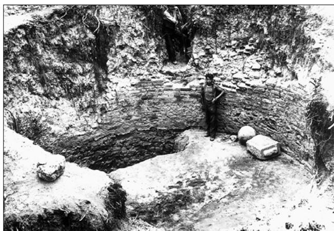
Obr. 9: Orlovice - pozůstatky cihelné věže hradu, odkrývané ve třicátých letech. (Foto archiv Památkového ústavu v Brně.)
