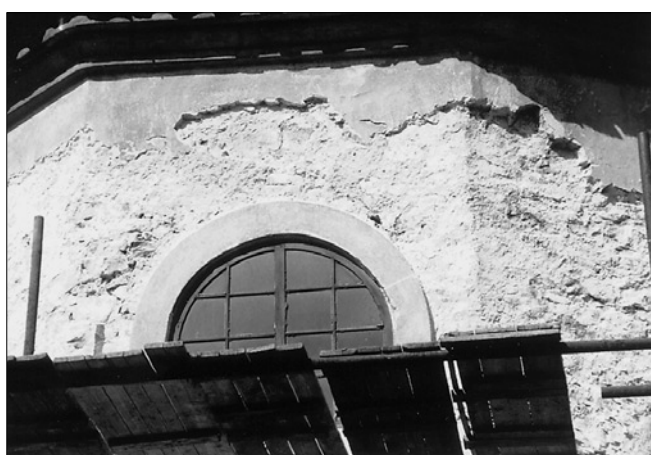
Obr. 3: Brandýs nad Labem, kostel sv. Petra. Detail východního průčelí presbytáře se zbytky středověké omítky na nároží. (Foto autor, 1995.)
