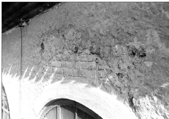
Obr. 2: Brandýs nad Labem, kostel sv. Petra. Detail záklenku zaniklého okna v jižním průčelí lodi. (Foto autor, 1995.)
