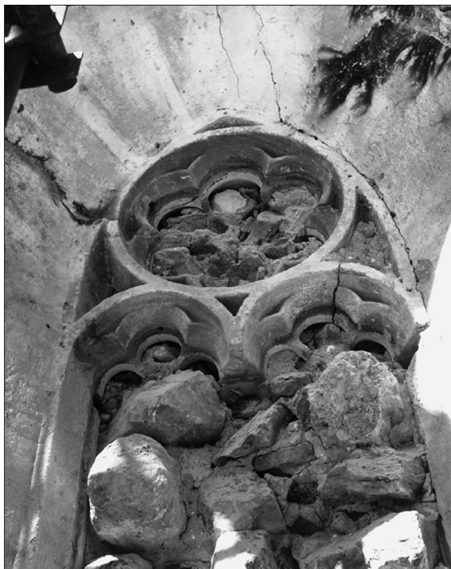
Obr. 1: Pohled na odhalené okenní ostění s kružbou, jižní strana lodi kostela Povýšení sv. Kříže. V horní části okenní špalety je patrná malovaná goticko renesanční iluzivní bosáž, vpravo nahoře se dochovala památka na požár stavby, k němuž došlo před barokní přestavbou lodi. (Foto K. Foud, 1995.)
