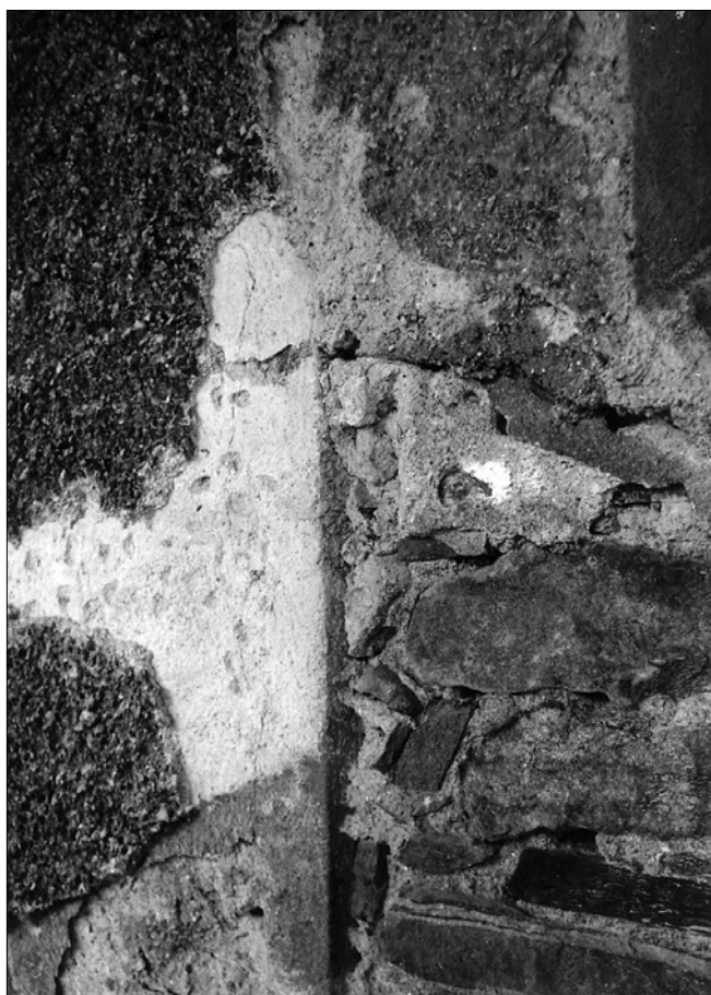
Obr. 1: Pohled na odhalené okenní ostění s kružbou, jižní strana lodi kostela Povýšení sv. Kříže. V horní části okenní špalety je patrná malovaná goticko renesanční iluzivní bosáž, vpravo nahoře se dochovala památka na požár stavby, k němuž došlo před barokní přestavbou lodi. (Foto K. Foud, 1995.)
