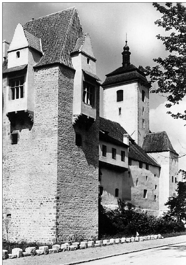
Obr. 1: Věž Jelenka od jihozápadu. Na spodní části je dobře viditelná armatura nároží, zcela vlevo zazděné okénko suterénu. Dobová pohlednice z archivu autora.
