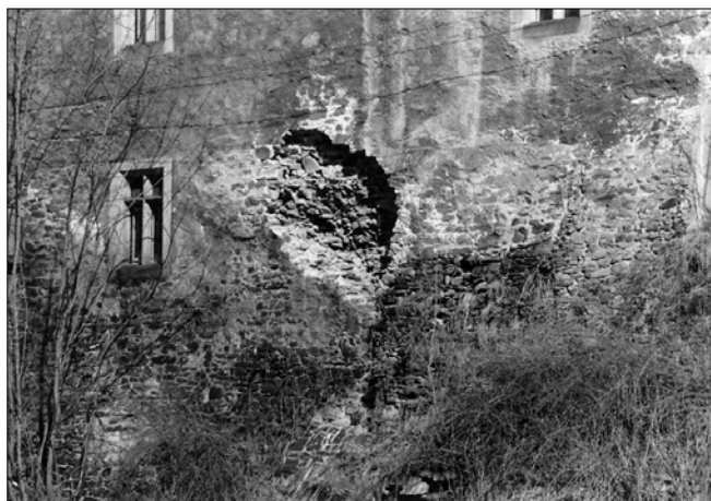
Obr. 5: Detail jižního průčelí v místech předpokládané druhé věže segmentového půdorysu. (Snímky 2 - 5 autor, 1996.)
