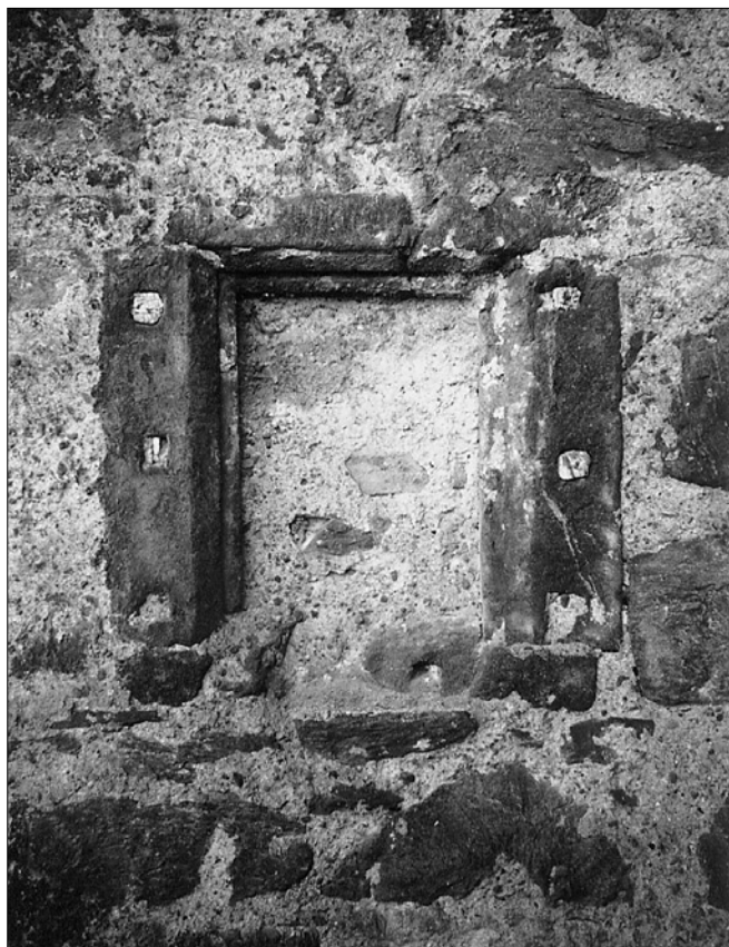
Obr. 2: Východní okénko suterénu věže Jelenky.
