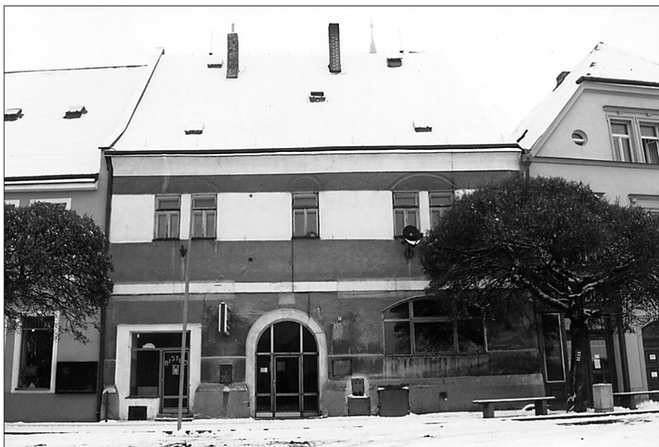
Obr. 1: Tachov čp. 59, hlavní průčelí. (Foto autor)
