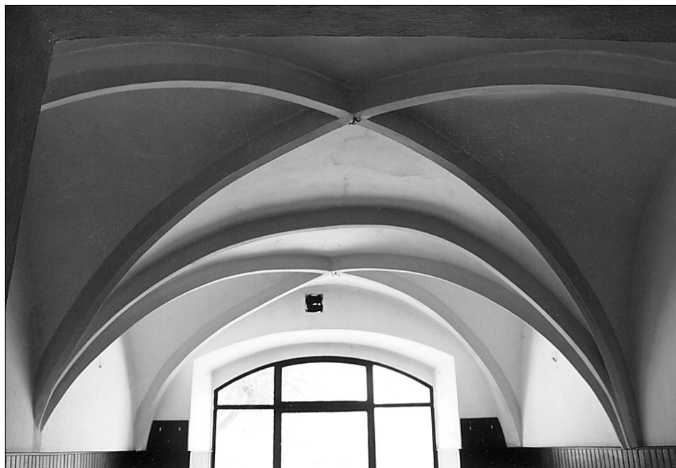
Obr. 4: Tachov čp. 59, žebrová klenba v přední místnosti přízemí pravého traktu. (Foto autor)
