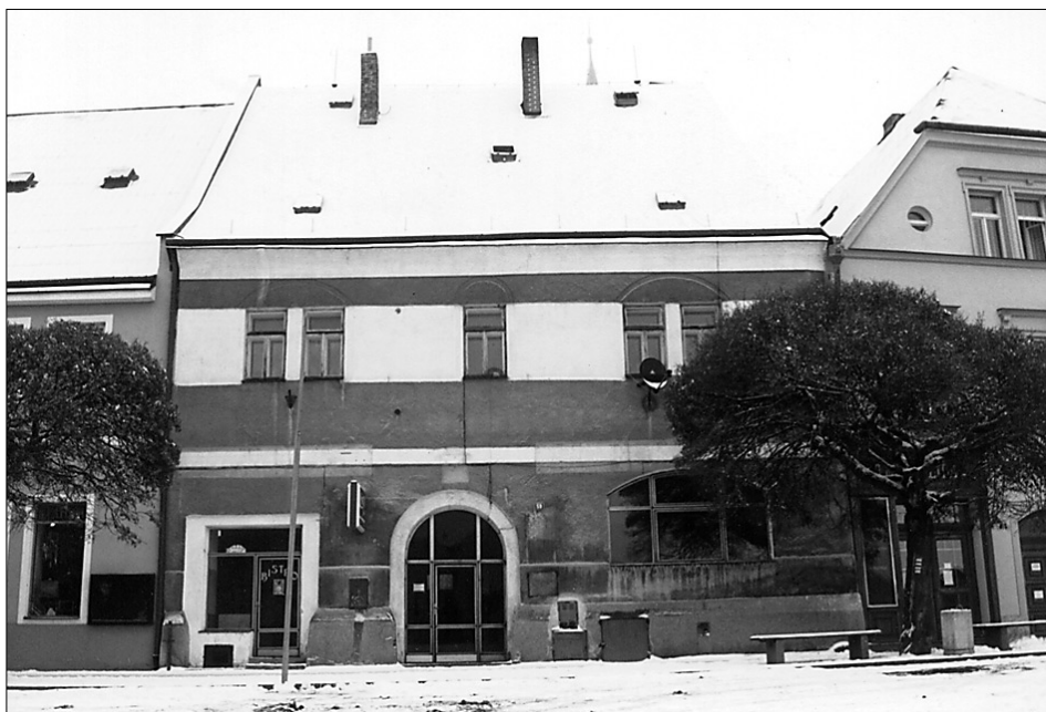
Obr. 1: Tachov čp. 59, hlavní průčelí. (Foto autor)
