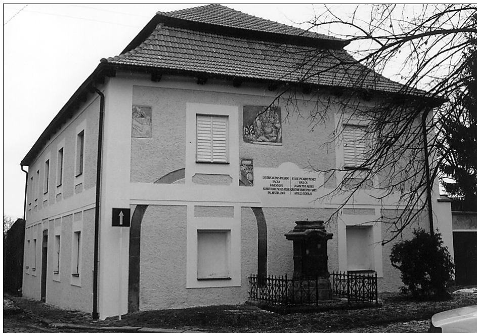
Obr. 4: Dům čp. 73/II - dnešní stav. (Foto E. Vyletová, 1995.)
