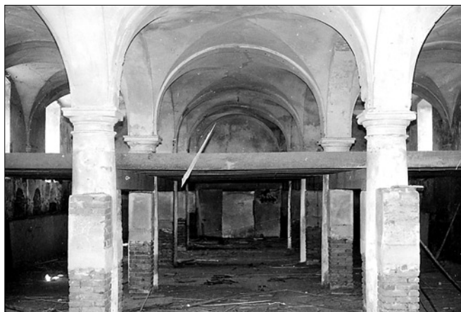
Obr. 33: Zákupy - hospodářský dvůr. Část velké konírny ve středu jižního křídla (foto P. Macek, 1982).
