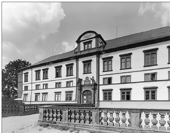
Obr. 27: Zákupy - zámek. Vstupní jižní průčelí. Stav před stávající obnovou (Foto SÚPP).
