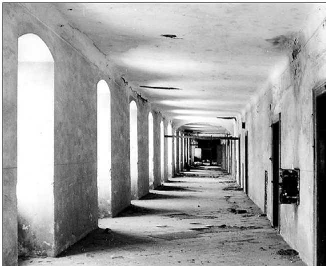
Obr. 12: Zákupy - hospodářský dvůr, chodba v 1. patře jižního křídla (foto P. Macek, 1982).
