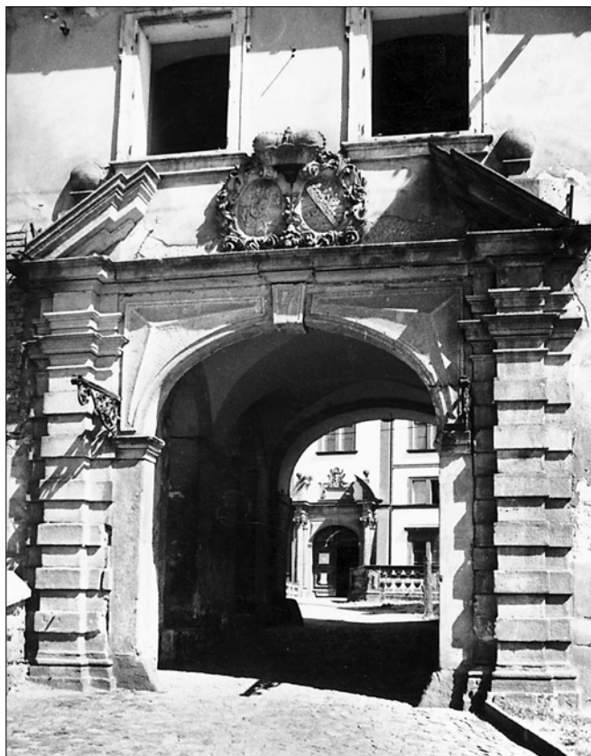
Obr. 11: Zákupy - hlavní portál předzámčí s průhledem k portálu zámku (foto P. Macek, 1982).
