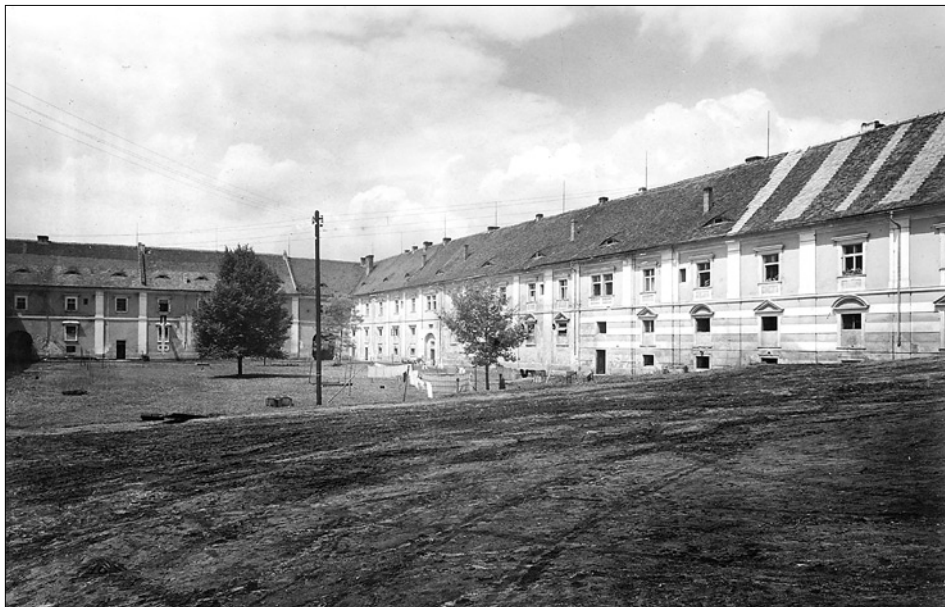
Obr. 35: Zákupy - hospodářský dvůr. Pohled na severní a západní dvorní průčelí. Stav z 60. let tohoto století (foto SÚPP).
