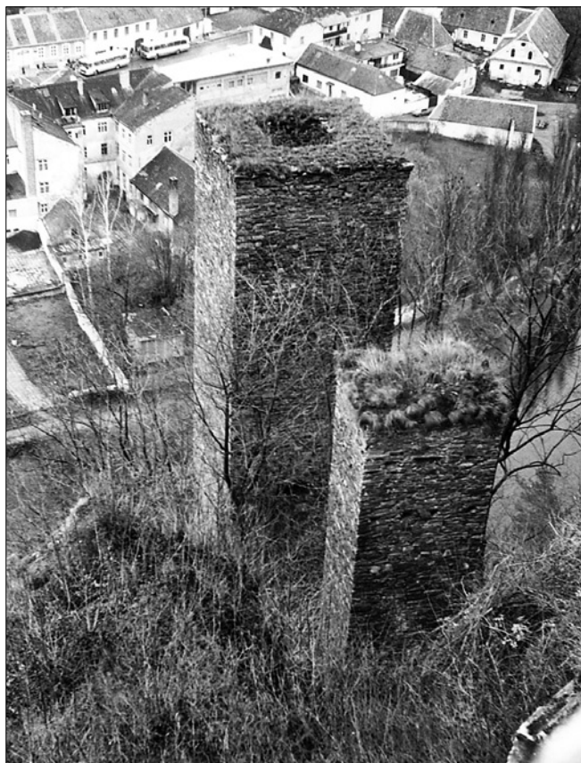
Obr. 14: Vranov nad Dyjí, zámek. Věž pro čerpání vody z řeky a pilíř mostu.
