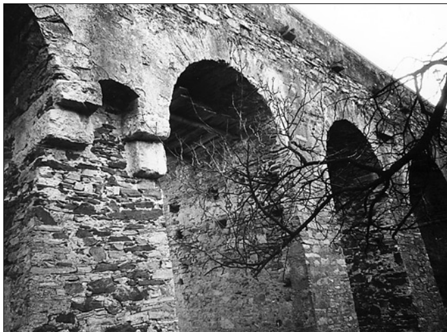
Obr. 11: Vranov nad Dyjí, zámek. Detail východní části mostu. Vlevo pozdně gotický pilíř s renesančními konzolami, upravo renesanční.
