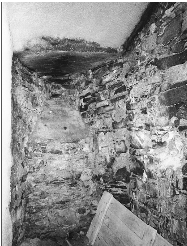
Obr. 5: Vranov nad Dyjí, zámek. Okénko gotického severního rizalitu směrem k vodní věži. K obvodní zdi je na spáru přiložena barokní přízdívka.
