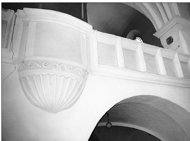
Obr. 7: Strakonice, kostel sv. Markéty. Detail parapetu kruchtí.
