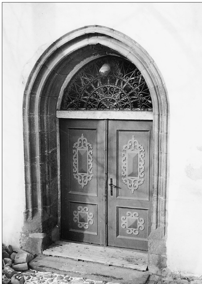
Obr. 9: Strakonice, kostel sv. Markéty. Gotický portál v jižním průčelí.
