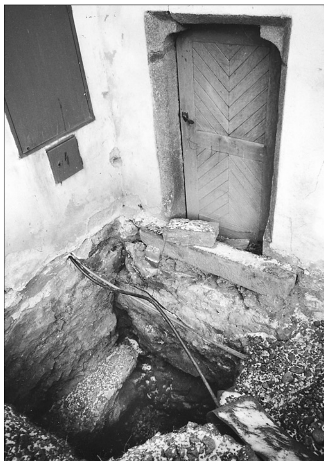
Obr. 3: Strakonice, kostel sv. Markéty. Sedlový portálek ke šnekovému schodišti na kruchtu v záp. čele objektu vedle věže se sondou, zachycující mělký základ kostelní lodi s dodatečně připojeným hlubším základem věže.
