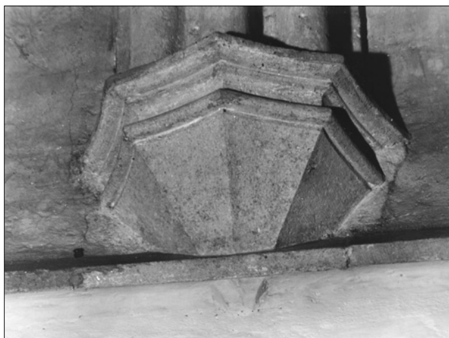
Obr. 18 Znojmo, kostel sv. Mikuláše. Trojloďní hala, konzola svazkové přípory v jižní boční lodi, protíná průběžnou podokenní římsu (foto z archivu PÚ v Brně, 1996).
