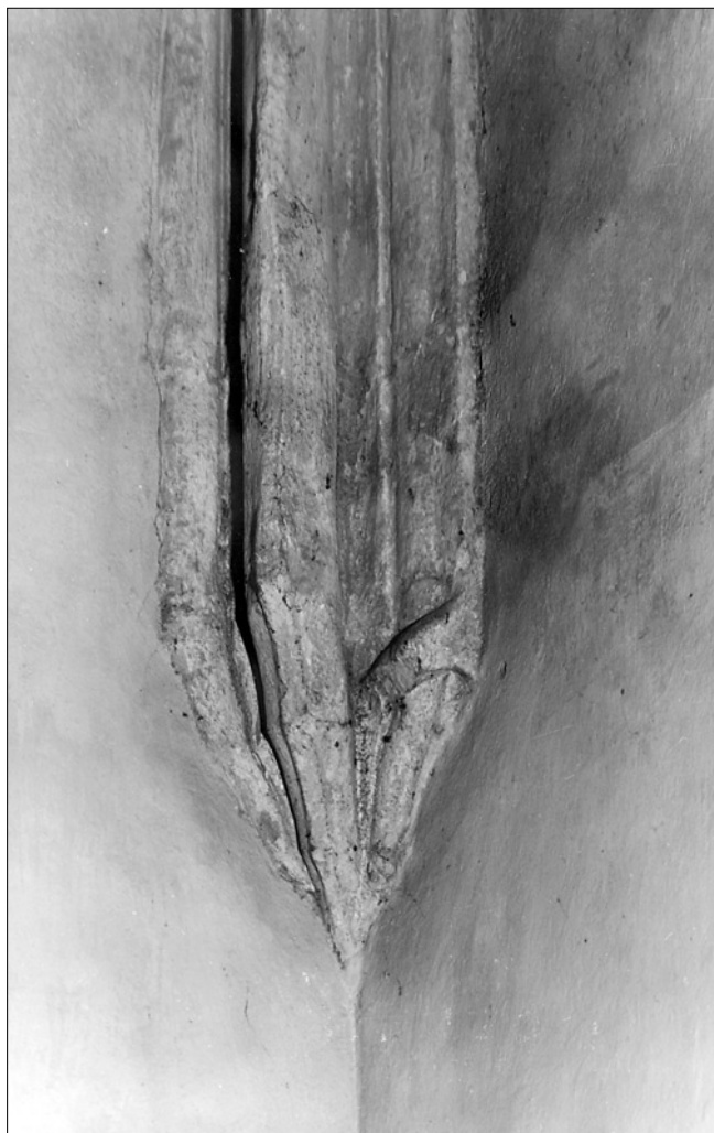
Obr. 10: Znojmo, kostel sv. Mikuláše. Trojlodní hala, patka svazkové přípo-ry v jihovýchodním koutě (foto z archivu PÚ v Brně, 1996).
