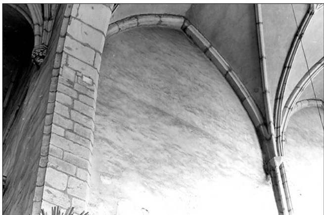
Obr. 7: Znojmo, kostel sv. Mikuláše. Severní ostění vítězného oblouku s přiléhající částí presbytáře a severní boční lodi, v presbytáři patrný horizontální ústupek na jižní straně severní věže (foto PÚ v Brně).
