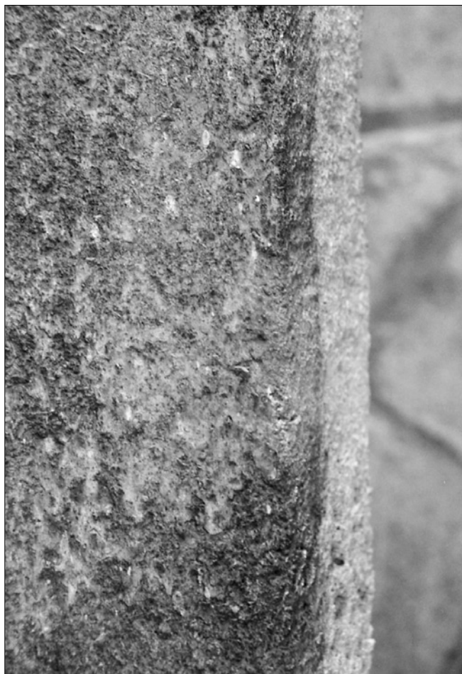
Obr. 8: Sedlec (okr. Kutná Hora), kostel Věch svatých, detail kvádrového zdiva záp. věžice s červeným nátěrem (foto autor).
