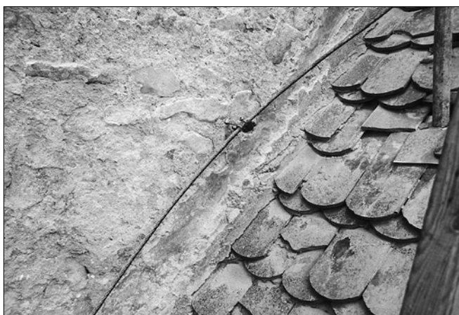
Obr. 5: Nechvalice (okr. Příbram), kostel sv. Mikuláše, detail východního štítu lodi s pásem kletovaně červeně natřené omítky nad krytinou presbytáře.
