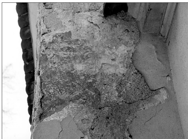
Obr. 9: Strážnice (okr. Příbram), kostel sv. Jana Křtitele, detail červeného pásu s rytými spárami na jv. nároží lodi.
