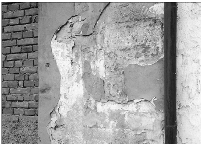
Obr. 3: Kutná Hora, dům čp. 3, detail zazděného okna na dvorním průčelí.
