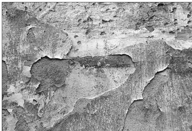
Obr. 6: Bubovice (okr. Příbram), detail sgrafitové omítky na průčelí fary, překryté omítkou se šedě malovaným pásem.
