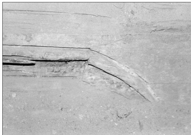
Obr. 7: Praha, Arcibiskupský palác, zakončení pozdně gotické profilace malovaného trámu nad kaplí, východní křídlo, II. patro (foto D. Sedláková, 1996).
