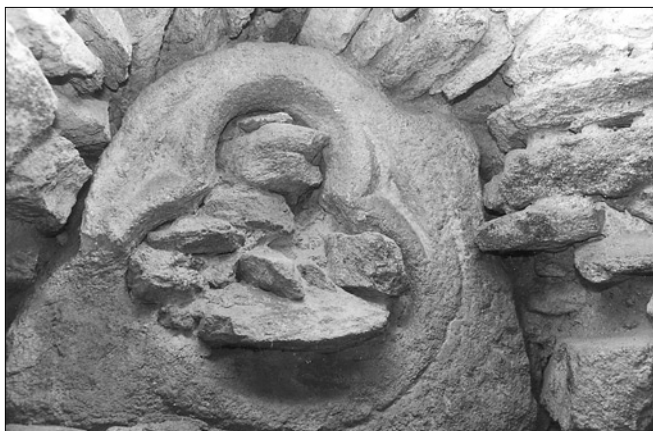
Obr. 3: Řečice (okr. Pelhřimov), kostel Nejsvětější Trojice. Kružba zazděného okénka v západním štítu střechy lodi, pohled z podkroví (foto J. Sommer, 1995).
