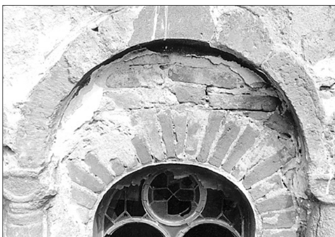
Obr. 14: Jakub, kostel sv. Jakuba. Východní okno v patře, situace záklenku (foto P. Kroupa, 1996).
