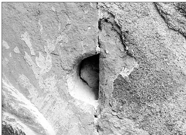
Obr. 17: Jakub, kostel sv. Jakuba. Deska s reliéfem sv. Jakuba, úchyt pro nosnou lana (foto J. Žizka, 1996).
