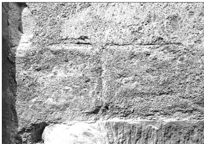
Obr. 16: Jakub, kostel sv. Jakuba. Detail II. románské omítky s podřezávanými spárami (foto P. Kroupa, 1996).
