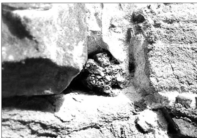
Obr. 15: Jakub, kostel sv. Jakuba. Zazděná část trámu lešení (foto P. Kroupa, 1996).
