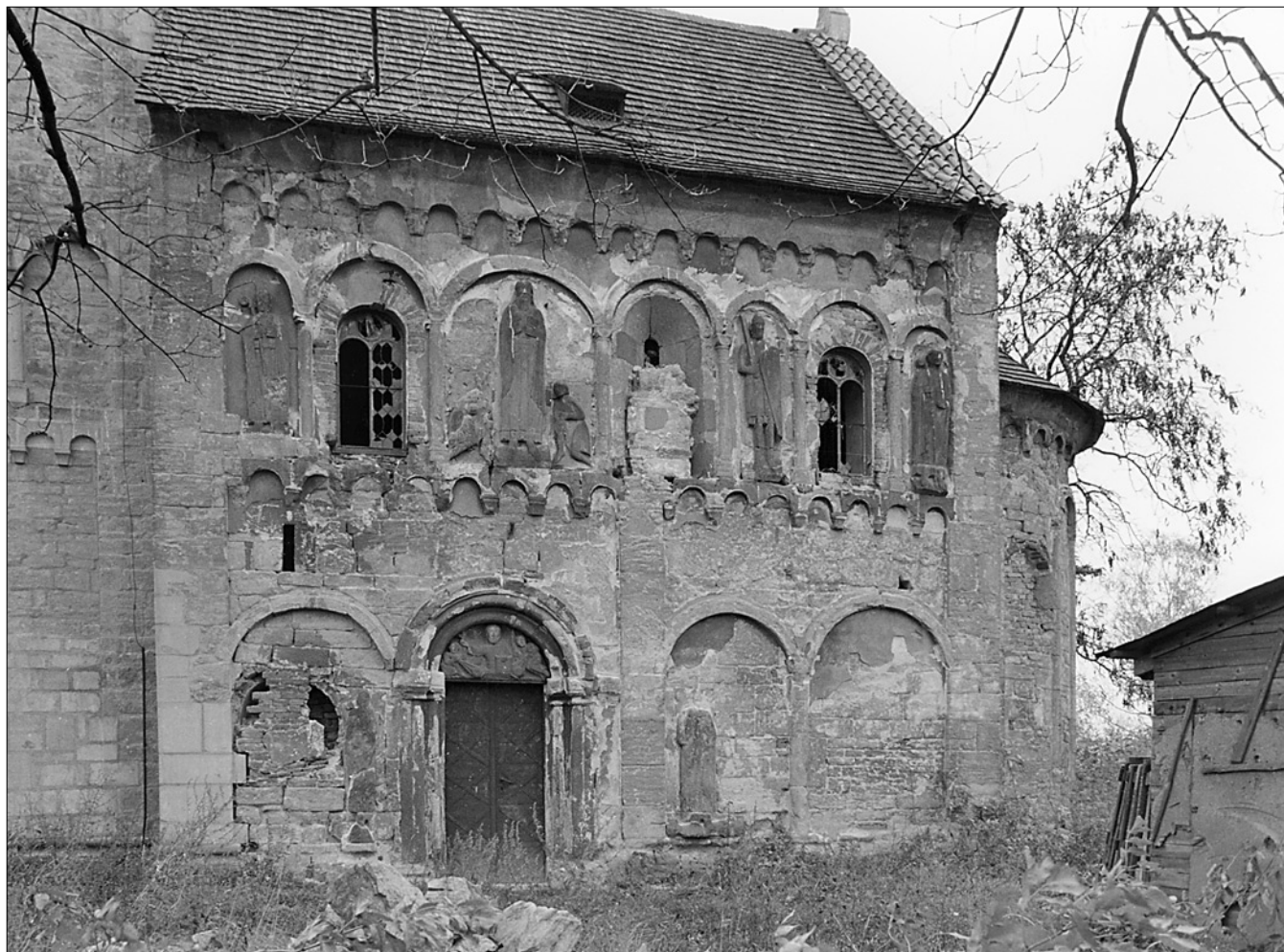
Obr. 2: Jakub, kostel sv. Jakuba. Celkový pohled na jižní průčelí lodi (foto V. Razím, 1997).
