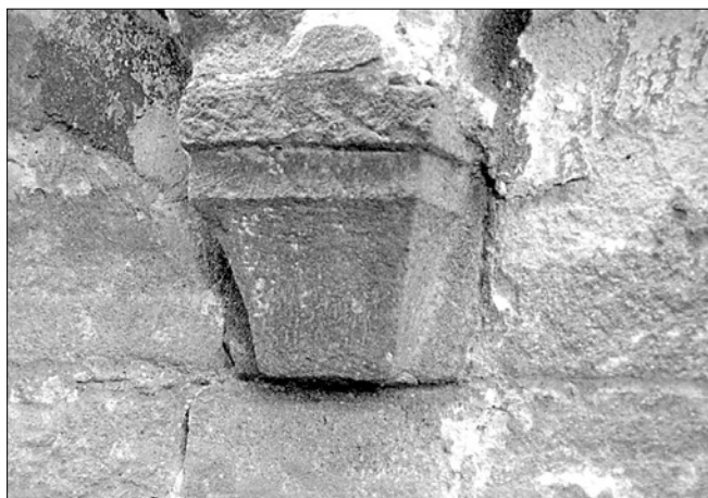
Obr. 7: Jakub, kostel sv. Jakuba. Konzolka obloučkového vlysu nad přízemím (foto P. Kroupa, 1996).
