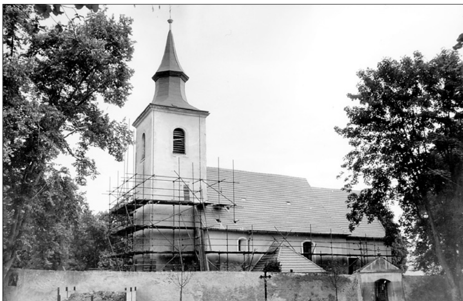
Obr. 1: Kostel sv. Jiljí v Heřmaní po částečném odstranění vnějších omítek, pohled od jihozápadu (foto J. Varhaník, 1996).
