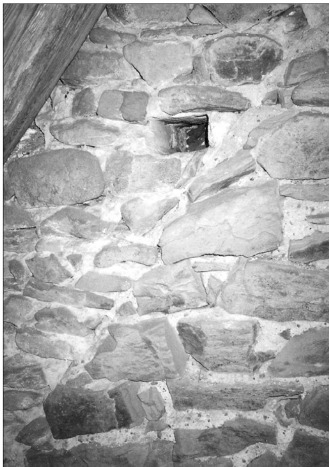
Obr. 14: Heřmaň, kostel sv. Jiljí. Nadezdívka východního štítu lodi s kapsou po trámku staršího krovu (foto J. Varhaník, 1996).
