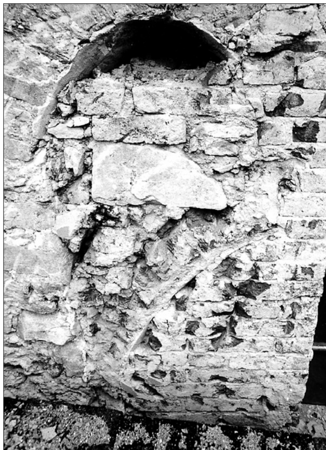
Obr. 8: Heřmaň, kostel sv. Jiljí. Trojice oken v západní části severního průčelí lodi v superpozici. Nahoře záklenek vnější špalety původního okna lodi, v jeho zaddívce ze smíšeného zdiva segment kruhového renesančního okna, zazděný nízkými cihlami při zřizování stávajícího okna barokního s ostěním z téhož materiálu (foto J. Varhaník, 1996).
