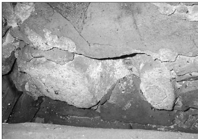
Obr. 7: Heřmaň, kostel sv. Jiljí. Architektonický článek, snad záklenek drobného okénka, zjištěný v severním lici zdi presbytáře, patrný z půdy sakristie (foto J. Varhaník, 1996).
