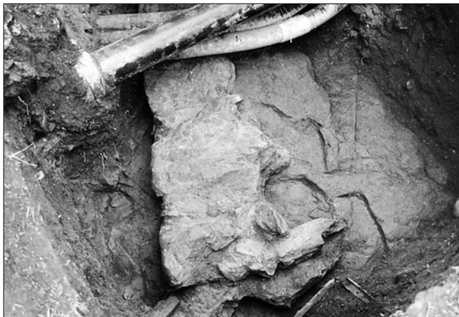
Obr. 2: Heřmaň, kaple sv. Alžběty. Pohled shora do sondy I. Blok základového zdiva severní stěny presbytáře kaple sv. Alžběty, vlevo dochovaný vnitřní líc (foto V. Komarová, 1996).
