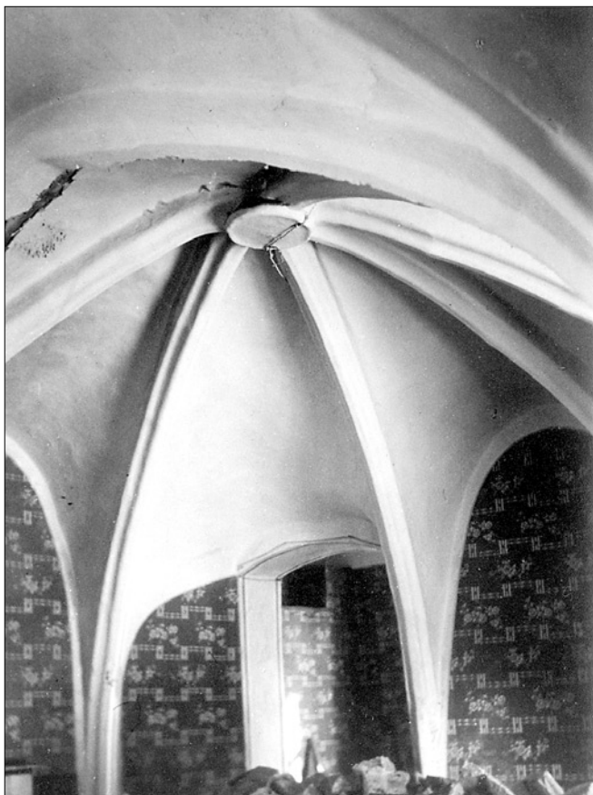
Obr. 17: Písek, kostel Povýšení sv. Kříže. Klenba závěru jižní boční kaple vestavěné v domě čp. 122 před demolicí v roce 1935 (foto Prácheňské muzeum v Písku).
