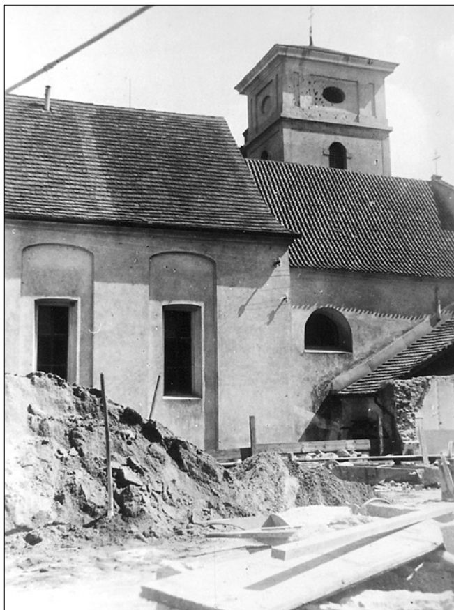
Obr. 18: Písek, kostel Povýšení sv. Kříže. Pohled na kostel od jihu v době demolice sousedního domu čp. 122 roku 1935 (foto Prácheňské muzeum v Písku).
