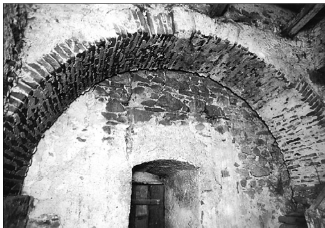
Obr. 6: Písek, kostel Povýšení sv. Kříže. Interiér prvního patra věže. Pohled k jihu (foto Jan Sommer, 1996).
