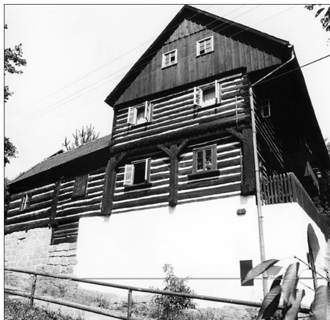
Obr. 21: Loubí, chalupa čp. 20 patří do skupiny chudších objektů, využívajících terénně nepříznivá svahitá místa v jižní části vesnice. Stavba reaguje na terénní situaci vysokou podezdívkou, resp. vyzděným suterénem s hospodářským prostorem (chlév). Její horní část je dochována (až na novodobý krov) v roubené výstavbě z 18. století, přičemž z této doby jsou tu i rozpoznatelné doklady dřevohlíněného komína.
