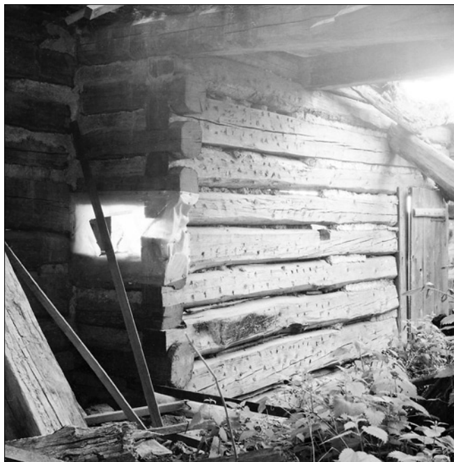
Obr. 25: Loubí, otisk někdejšího dřevohlíněného provedení komína nad hlavním topeništěm na roubené stěně síně v patře domu čp. 46. Konstrukce komína, resp. dole otevřeného dymníku byla kombinovaná - vlevo jsou u nároží odřezány trámy jeho roubené stěny, stopy po zatlučení kolíků vymezují jeho vnitřek z hlíněnou vymazávkou a uprostřed šikmého vymezení této plochy upravo je dlab po zakotvení trámu jeho protější stěny, která tudíž musela být hrázdná.
