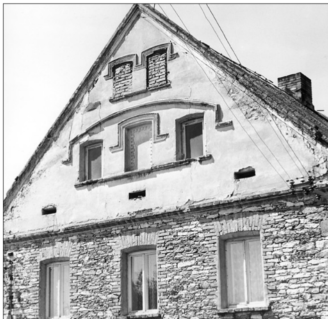
Obr. 27: Loubí, detail štítu domu usedlosti čp. 48 ze 3. čtvrtiny 19. století, už se segmentovými záklenky oken a historizujícími prvky ve štukové výzdobě štítu. Ten už nahore nemá polovalbu a dole má ležatá větrací okénka, naznačující počínající oblubu půdních nadezdívek.
