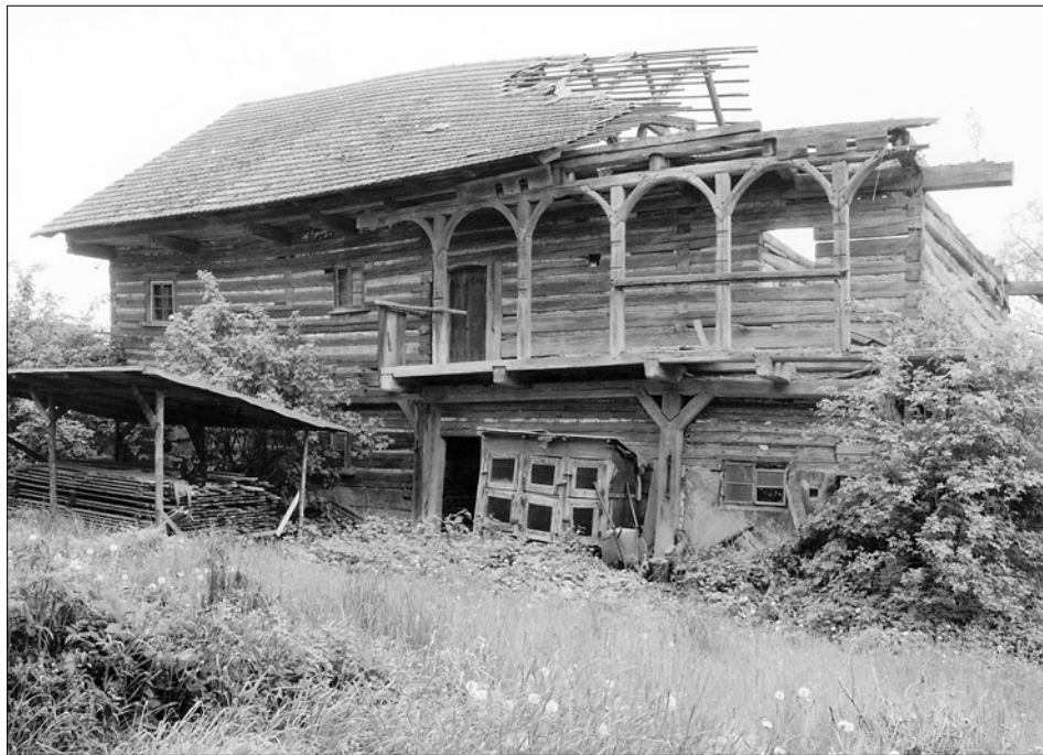
Obr. 26: Loubí, celkový pohled ze dvora na starší, dřevěný dům v usedlosti čp. 46, před jeho rozebráním pro museum lidové architektury v Zubrnici. Patrný je zbytek pavlače s arkádou starobylého provedení, která ze tří stran lemovala patro v zadní části domu.
