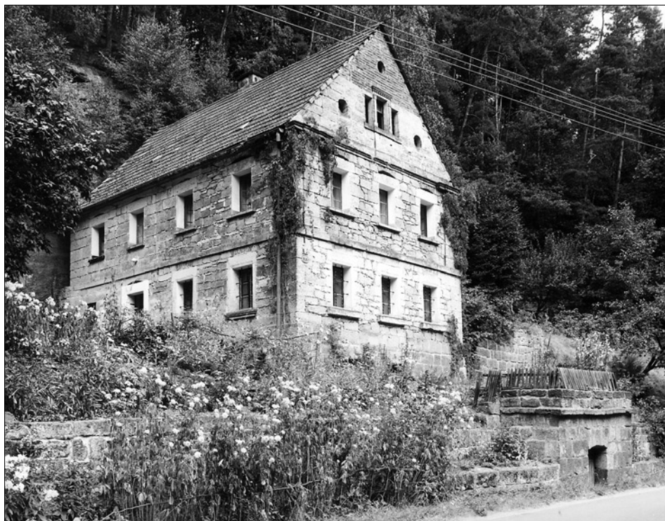
Obr. 22: Loubí, dům čp. 26, situovaný rovněž ve svahu jižně od návsi, představuje ojedinělou stavbu ze 2. poloviny 19. století jednak svým méně obvyklým dispozičním řešením, ale zejména výrazným průčelím, provedením převážně z neomítaného kamenného zdiva. V něm se uplatňují i jednoduché kamenické články, zčásti druhotně použité.
