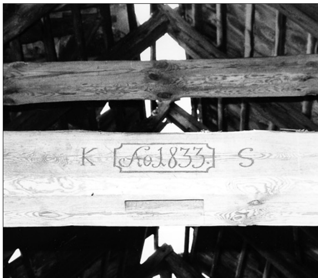
Obr. 8: Loubí, stodola v usedlosti čp. 1, postavená roku 1833, tedy 10 let před požárem, který vznikl v jejím těsném sousedství; a - detail kamenický precizně provedeného zdiva z pískovcových kvádrů s typickou fabionovou římsou nad půlelipsoidě klenutým vjezdem na mlat, s polodrážkami pro vratové sloupky i dosednutí obou křídel; b - detail datování na vazném trámu na jižní straně mlatu.
