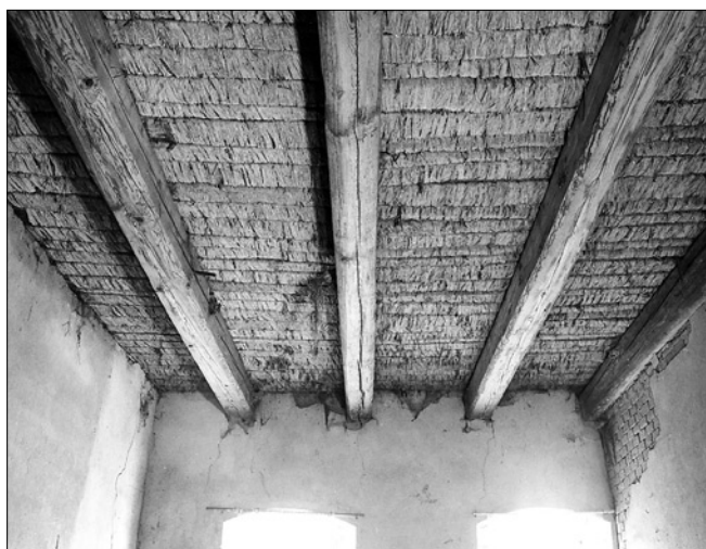
Obr. 15: Loubí, typická konstrukce zřejmě nedokončeného stropu v jedné z komor v patře domu čp. 7, která zčásti respektuje tehdejší požadavky na protipožární odolnost povrchu dřevěných konstrukcí. Trámový strop má záklop z tyčí, omotaných slaměnými povrisly, spodní strana záklopu zřejmě měla být opatřena hliněnou omazávkou. V obytných místnostech se užívala varianta této konstrukce se subtilnějším podhledem rovněž z opletané tyčoviny s hliněnou omazávkou, zpravidla s odsazeným fabionovým okrajem.
