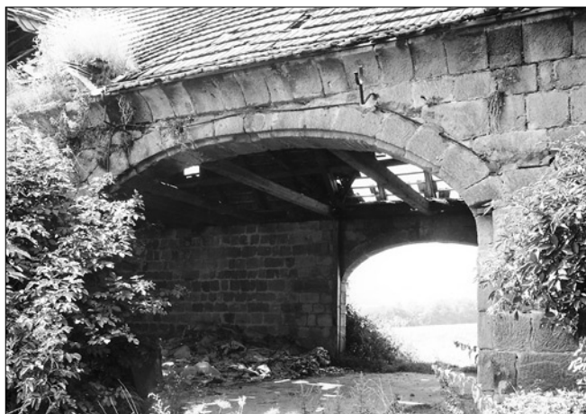
Obr. 8: Loubí, stodola v usedlosti čp. 1, postavená roku 1833, tedy 10 let před požárem, který vznikl v jejím těsném sousedství; a - detail kamenický precizně provedeného zdiva z pískovcových kvádrů s typickou fabionovou římsou nad půlelipsoidě klenutým vjezdem na mlat, s polodrážkami pro vratové sloupky i dosednutí obou křídel; b - detail datování na vazném trámu na jižní straně mlatu.
