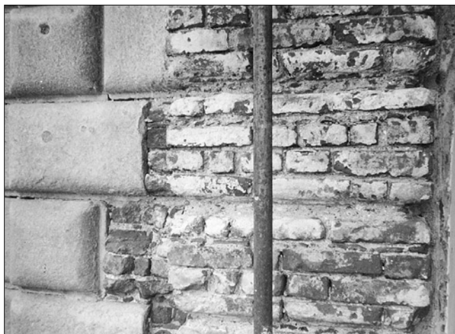
Obr. 4: Kamenná bosáž a cihelné tvarovky Budějovické brány v Českém Krumlově (foto autor, 1995).
