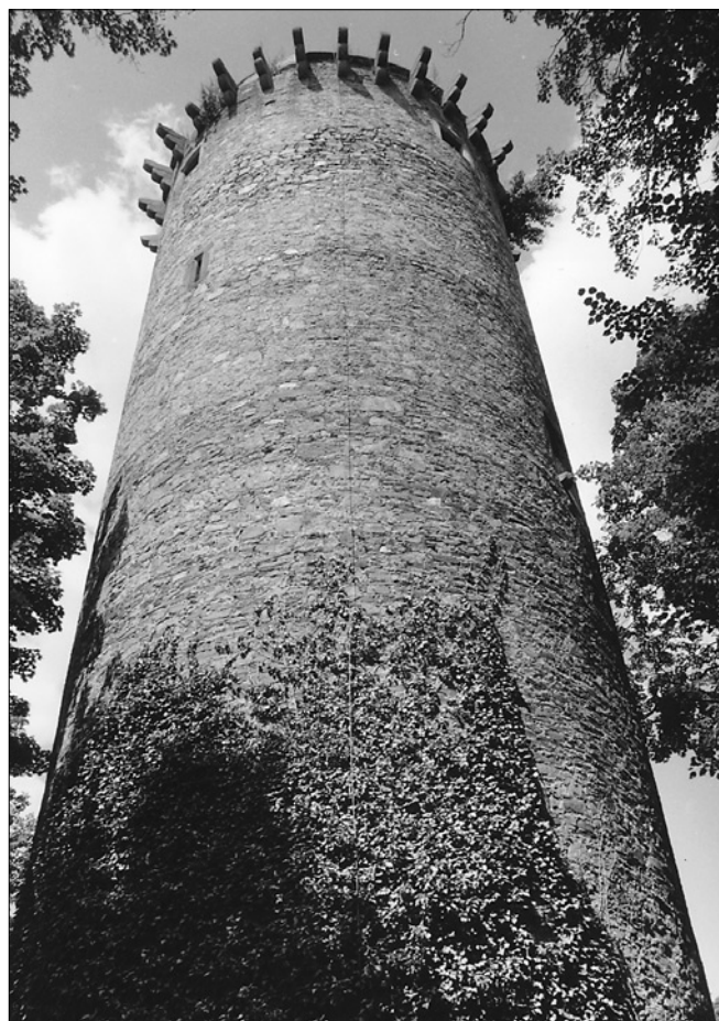
Obr. 17: Rožmberk, válcová věž Horního hradu, zv. Jakobínka. Vpravo portálek do 1. patra, vlevo typ okénka uplatněný ve 2. a 3. patře, nahoře pod krakorcí větší okna posledního patra (foto autor, 1996).
