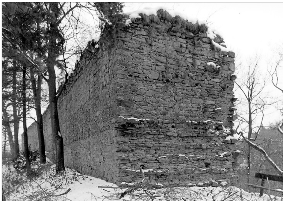
Obr. 23: Bechyně, štítová zeď jižně od hradu, zv. Čertova. Šmorce západního zakončení zdi nasvědčují ne realizovanému záměru napojení stavební části neznámé podoby (foto autor, 1997).
