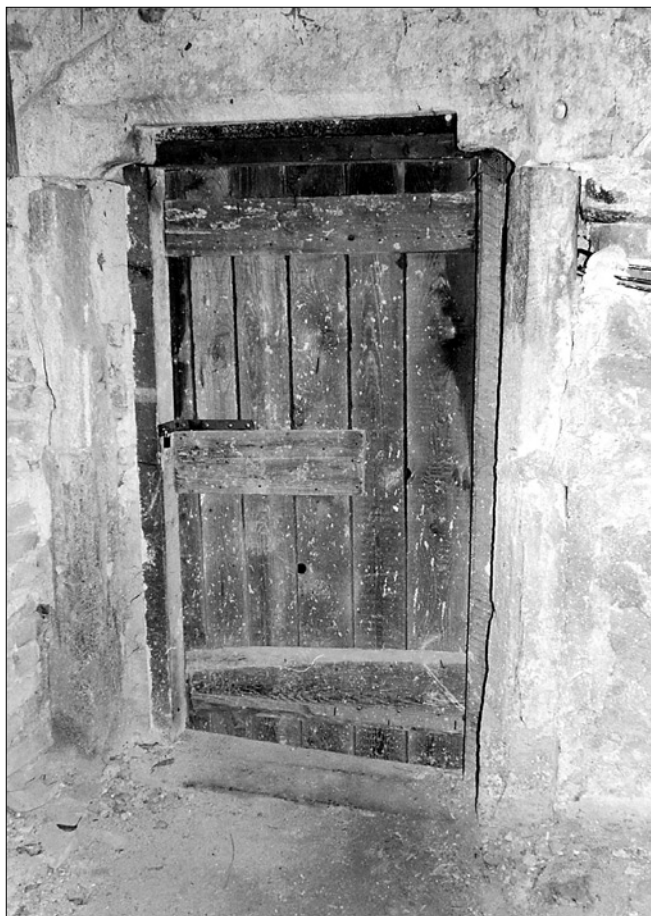
Obr. 14: Český Krumlov, předsunutá bašta hradu, sedlový portálek interiéru, složený druhotně z několika částí různého původu (foto autor, 1996).
