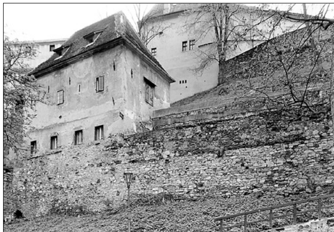
Obr. 9: Český Krumlov, budova tzv. prachárny čp. 63, vystavěná na hradební zdi. Pod dolními okny vystupují stříšky stínek cimbuří. Hradební zeď s cimbuřím pokračuje západním směrem (vpravo), (foto autor, 1997).
