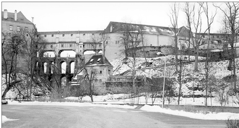
Obr. 8: Český Krumlov, západní část Horního hradu od severu (vlevo), most Na Plášti, zámecké divadlo a dům čp. 177, zcela vpravo pokračující můstek do zámecké zahrady. Před divadlem zeď bývalého příhrádku, vlevo dole patrová budova tzv. prachárny s navazující hradební zdí, zcela vpravo ve svahu relikt hradební věže (bašty), (foto autor, 1996).
