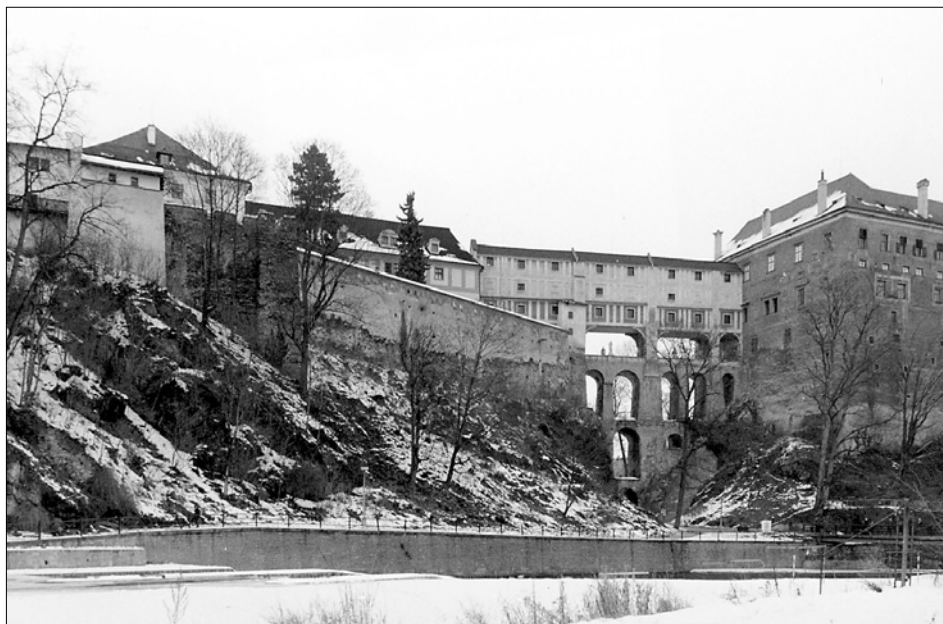
Obr. 4: Český Krumlov, západní část Horního hradu od jihu (vpravo), most Na Plášti, zámecké divadlo a dům čp. 177 na místě štítové zdi, zv. Plášť (zcela vlevo). Před domem terasní zdi nad řekou, jejichž levá, omítnutá část patrně obsahuje jižní zakončení štítové zdi. Vpředu skalnatý říční sráz, jehož vystupující část je zřejmě pokračováním skály, která byla využita při stavbě fortifikace (foto autor, 1996).
