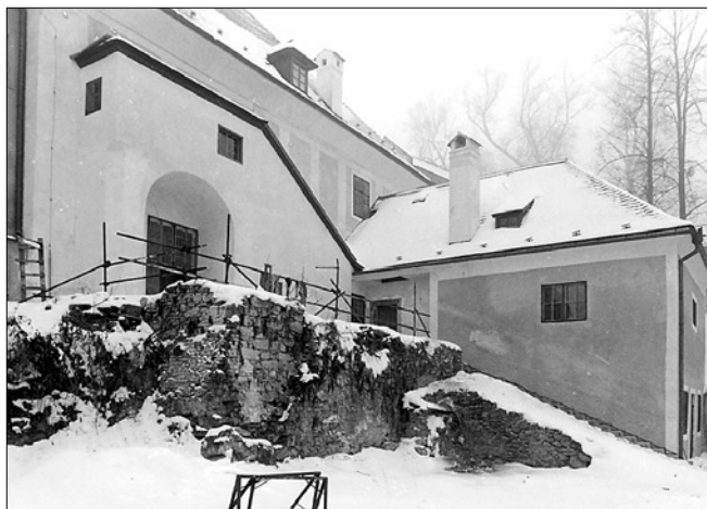
Obr. 7: Český Krumlov, vnitřní prostor příhrádku Pláště od severovýchodu. Vlevo severní průčelí hlavní části domu čp. 177, vpravo severní křídlo, při němž patrně byla umístěna brána. Vlevo vstupní otvor pod záklenkem, který mohl vzniknout na místě brány do prostoru za štítovou zdi. Vpředu zděná rampa nejasné geneze (foto autor, 1997).
