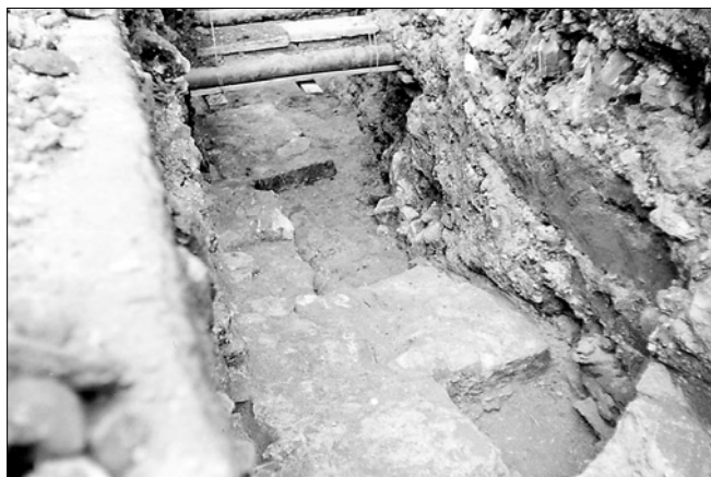
Obr. 3: Žatec, pohled od jihu na část východní stěny Čeradické brány v rýze teplovodu se středovým a severním opěrným pilířem (foto P. Holodňák, 1996).
