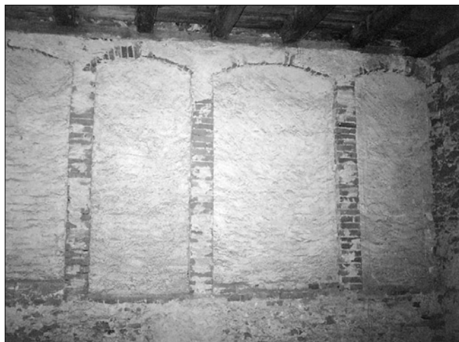
Obr. 4: Telč, kostel Jména Ježíš. Vnitřní líc arkády mezivěží před odstraněním zazdívkou (foto J. Bláha, 1996).
