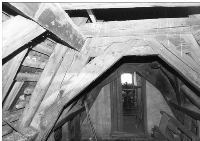
Obr. 7: Telč, kostel Jména Ježíš. Detail krovu mezi oběma věžemi (foto J. Bláha, 1996).
