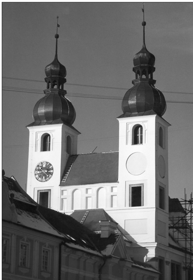
Obr. 6: Telč, kostel Jména Ježíš. Východní průčelí po opravě (foto B. Bína, 1996).
