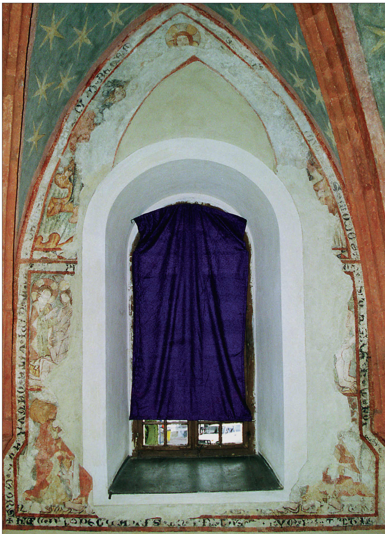
Obr. 7: Dolní Bukovsko, kostel Narození Panny Marie, jižní stěna presbytáře, celkový pohled (foto A. Martan).
