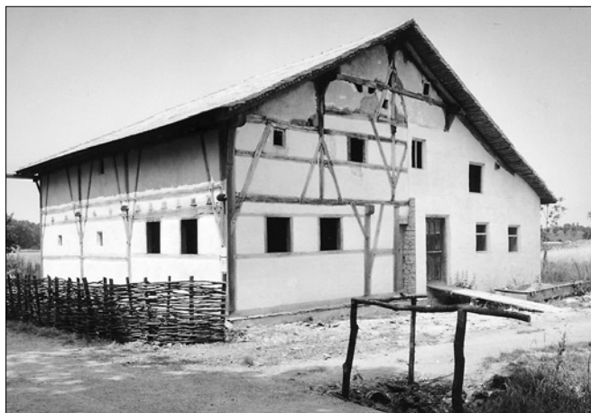
Obr. 1: Dokončená hrubá stavba prvního z altmühlských domů ve středověkém okrsku franckého skanzenu v Bad Windsheim. Dům je z vesnice Ochsenfeld mezi Eichstättem a Neuburgem na Dunaji a jeho hrázděná konstrukce, autenticky dochovaná na průčelí v levé horní části štítové stěny, je z roku 1454 - 55, viz. pozn. 5, s. 226 (foto J. Škabrada, 1990).
