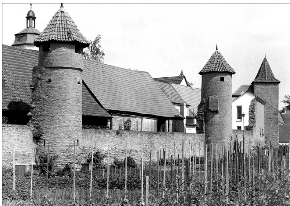
Obr. 7: Mainbernheim (Franky), část městského opevnění s věžemi a poměrně tenkými kurtinami, jejichž původní výška a horní zakončení jsou patrné na stranách věží. Pohled z vnější strany.
