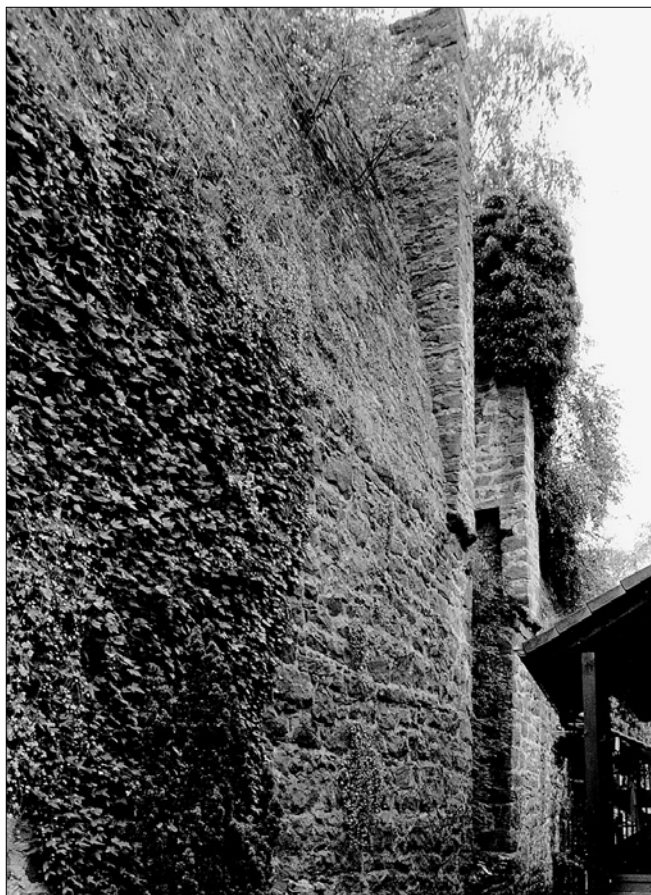
Obr. 10: Miltenberg (Franky), vnitřní líc hradební kurtiny s dovnitř otevřenou hranolovou věží. Hradební zeď byla druhotně zvýšena nástavbou s šikmým vnitřním lícem, která zakryla vchody z patra věže na původní ochozy kurtin.
