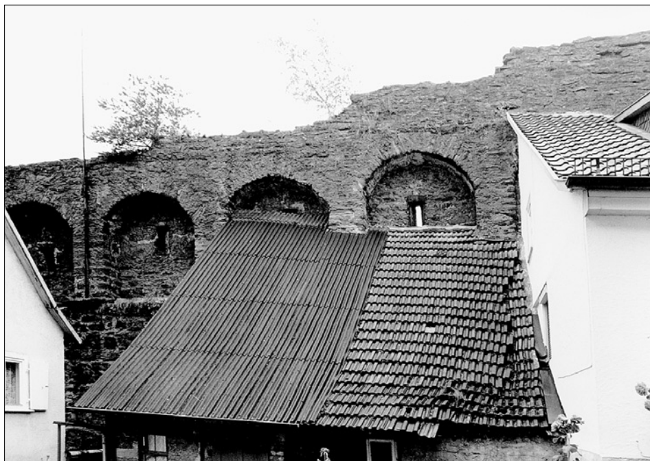
Obr. 11: Miltenberg (Franky), vnitřní líc hradební kurtiny s fragmentem horního zakončení sbíhavého profilu (vpravo) a se střelnými v níkách ve zvýšené úrovni nad terénem.
