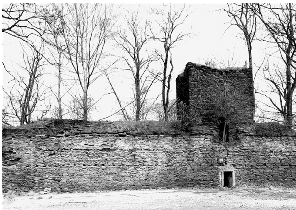
Obr. 5: Freiberg (Sasko), vnitřní líc hradební zdi s pultovou střškou a s jednou z hranolových věží. Střška je konstrukčně svázána s týlní stranou věže a přerušena v místě vchodu do patra. Vstup do přízemí věže zřízen druhotně.
