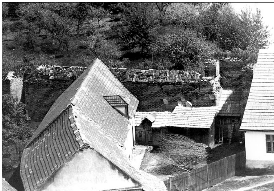
Obr. 1: Nymburk, vnitřní líc hradební zdi, završený dovnitř skloněnou pultovou stříškou, která je tvořena několika řadami cihel. Kurtina je na obou stranách vymezena relikty dovnitř otevřených hranolových věží. Celá část opevnění na jihovýchodní straně města byla rekonstruována po roce 1905, přitom však nebyla rozpoznána autenticita původního zakončení hradby, které bylo odstraněno a nahrazeno ochozem a cimburím (snímek z věže děkanského kostela, před rokem 1905, Městské muzeum v Nymburce).
