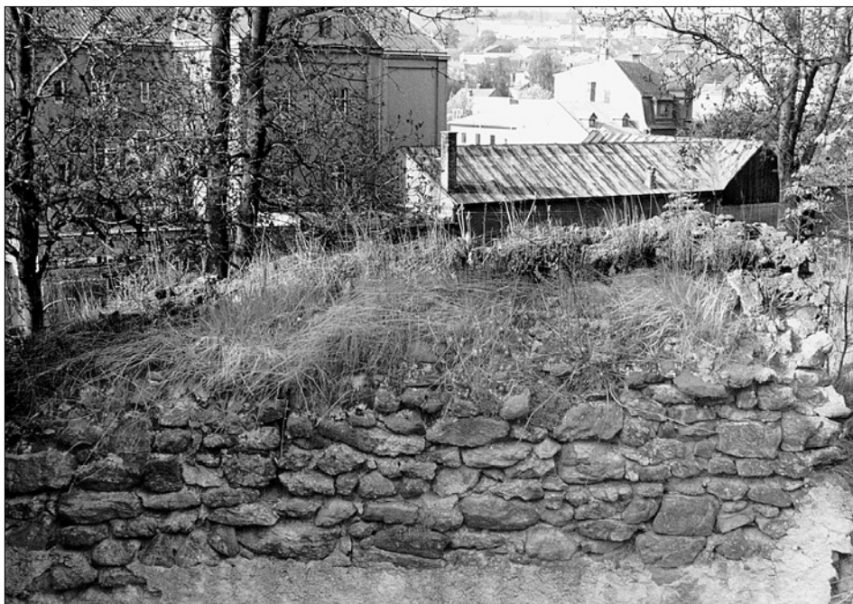
Obr. 4: Tachov, detail koruny hradební zdi v jižní části města, za čp. 126 v Havlíčkově ulici. Pohled z městské strany na postupně zanikající relikt originální pultové střšky.
