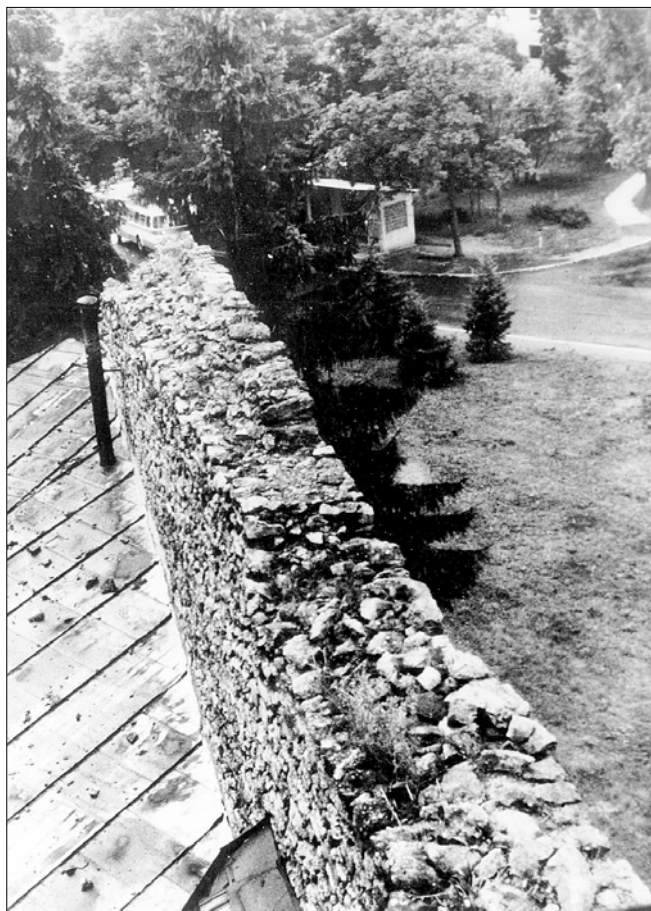
Obr. 3: Tachov, detail koruny hradební zdi na západní straně města ukazuje, že zeď vrcholila dovnitř skloněnou pultovou stříškou. Tomu nasvědčují také rozbor starých fotografií a zobrazení, stejně jako stavební podoba hradebních věží a jejich napojení na kurtiny. Snímek zachycuje stav před současnou rekonstrukcí, která nerespektovala originální tvar hradební koruny a aplikovala zde ochoz s předprsní zídou (snímek z archivu Památkového ústavu v Plzni z doby před zahájením rekonstrukce).
