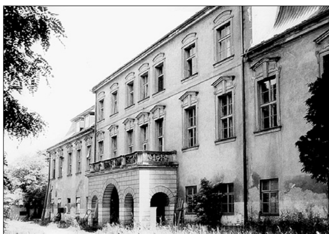
Obr. 15: Cerekvice nad Bystřicí. Severní průčelí zámku (foto L. Svoboda, 1978).
