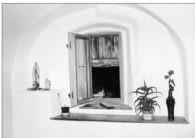
Obr. 13: Krnín, čp. 1. Nika v jižní stěně někdejší světnice, do níž je vloženo jediné dochované čelní okno středověké obytné místnosti.
