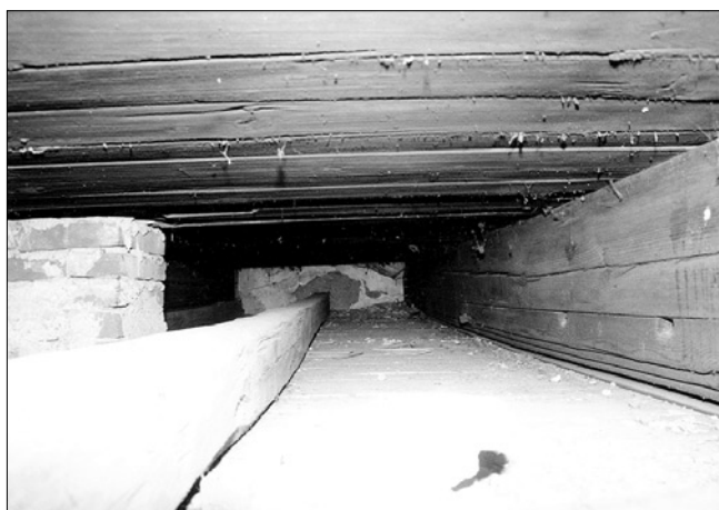
Obr. 15: Krnín, čp. 1. Průhled do prostoru mezi podhledem a stropem někdejší obytné místnosti, vpravo je prostřední (mohutnější) trám středověkého stropu.
