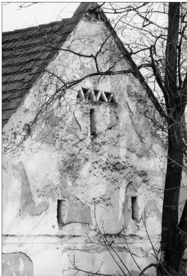
Obr. 21: Krnín, čp. 1. Detailní pohled na štít špýcharového bloku protějšího domu čp. 3 s obdobným cihlovým dekorem.
