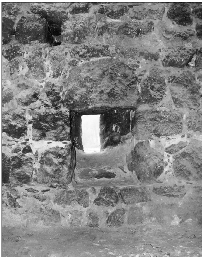
Obr. 9: Hrad Loket, pozdně románské okno v suterénu Markrabského domu při pohledu z interiéru.
