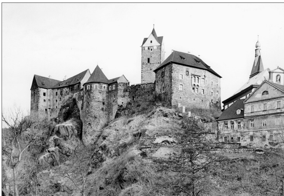
Obr. 1: Hrad Loket v pohledu od severozápadu, stav r. 1997 (foto z archivu PÚSC).
