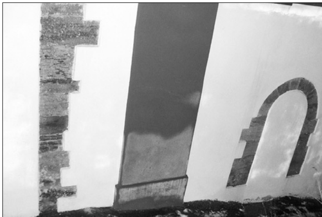
Obr. 5: Pozdně románské reliktů na severním průčelí kostela sv. Václava.
