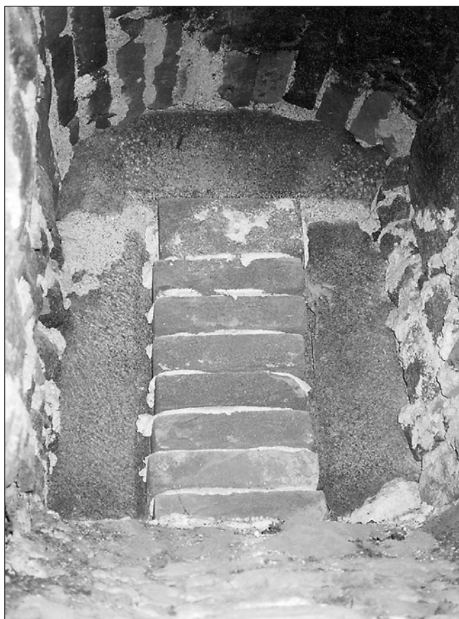
Obr. 11: Hrad Orlík, zazděné ostění dělové komory 3/5 A v horní části třetího patra věže (foto autor, 1997).
