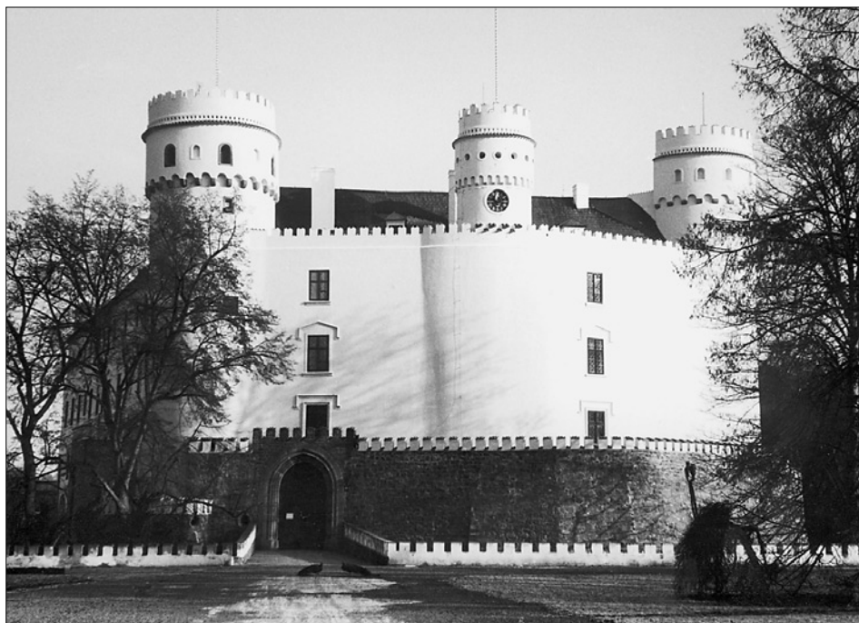
Obr. 2: Hrad Orlík od jihozápadu. Dobře je viditelné zaoblení štítové zdi pod prostřední věží. Pod konzolami vyloženého patra bateriové věže vlevo se uplatňuje intaktní pravoúhlé ostění nejvyšší dělové komory 4/6 A (foto autor, 1996).
