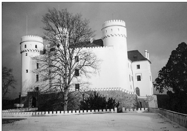
Obr. 1: Hrad Orlík od jihu z prostoru někdejšího předhradí, vpravo rizalit s presbyteriem kaple (foto autor, 1996).
