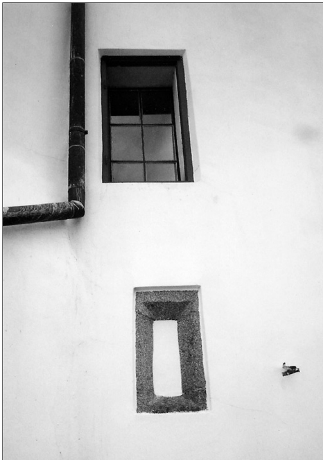
Obr. 17: Hrad Orlík, zazděné ostění dělové komory 1/2 B (foto autor, 1997).
