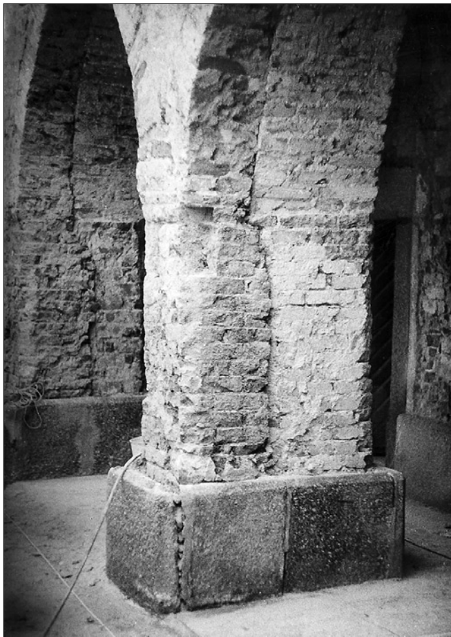
Obr. 22: Hrad Orlík, pilíře arkád jihovýchodního křídla po odstranění omítek. K původním gotickým arkádám přiléhá na nádvoří straně renesanční přízdívka (foto A. Vrátný, 1991).
