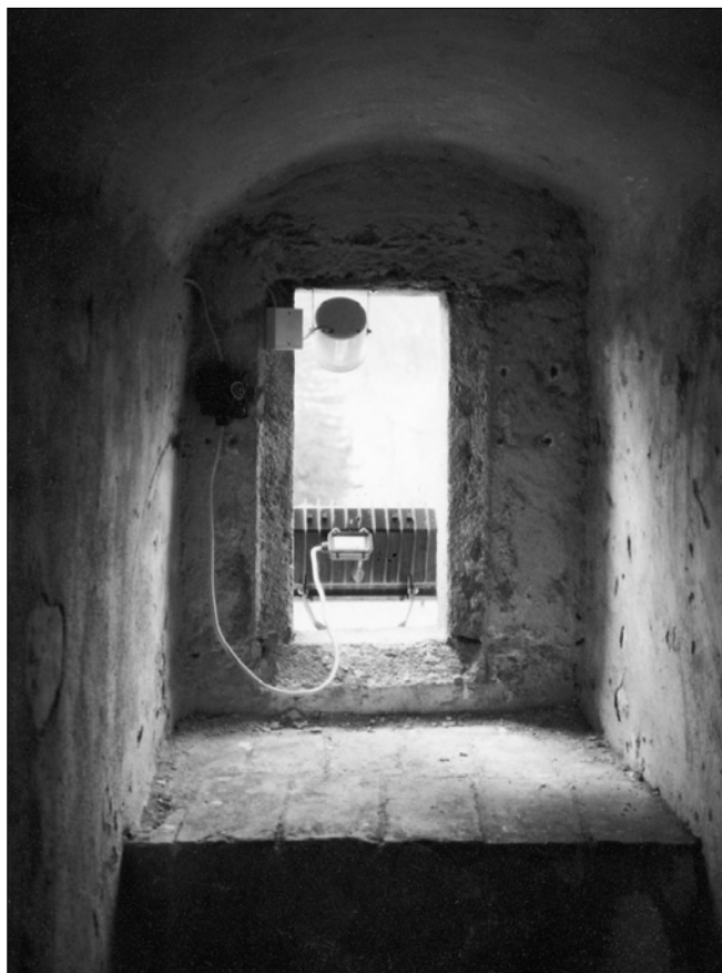
Obr. 10: Hrad Orlík, dělová komora 4/6 A ve čtvrtém patře věže (foto autor, 1997).
