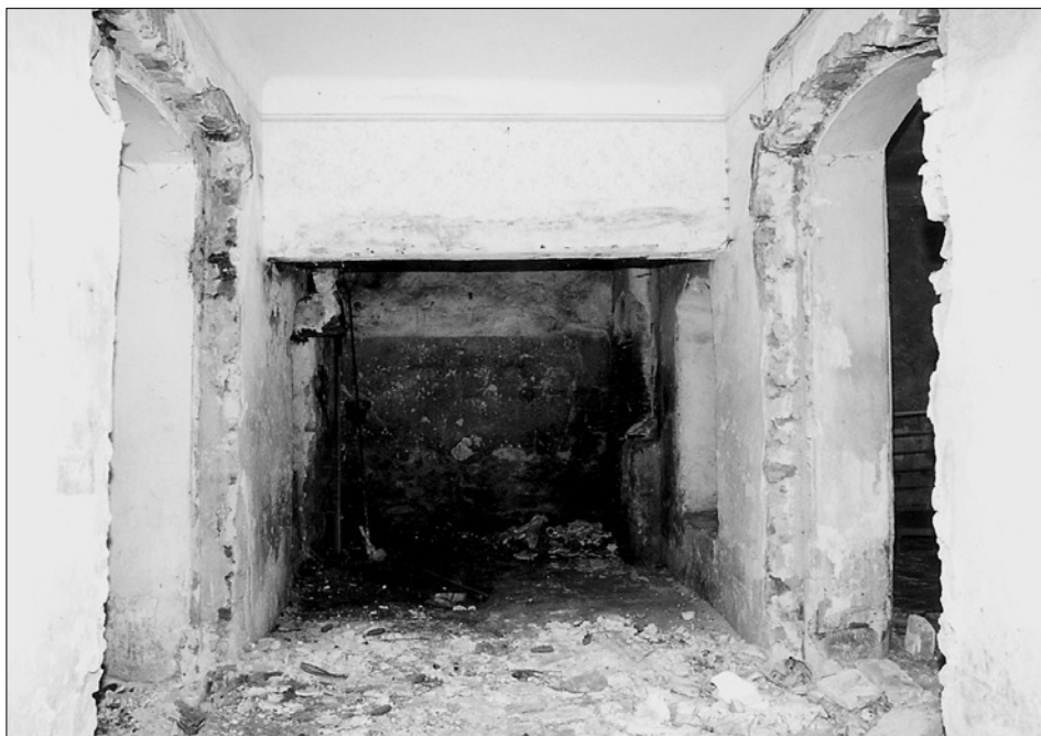
Obr. 3: Brandýs nad Labem čp. 153 (okr. Praha - východ), pohled od vstupu do síně ke kuchyni spodního severního bytu, jejíž dymník byl vynášen jednoduchým trémovým překladem.
