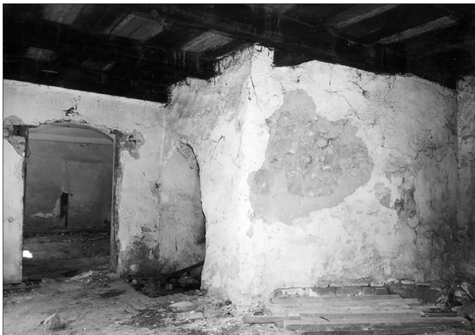
Obr. 2: Brandýs nad Labem čp. 153 (okr. Praha - východ), zděný blok valeně klenuté černé kuchyně spodního jižního bytu v koutu velké vstupní síně s trémovým stropem.
