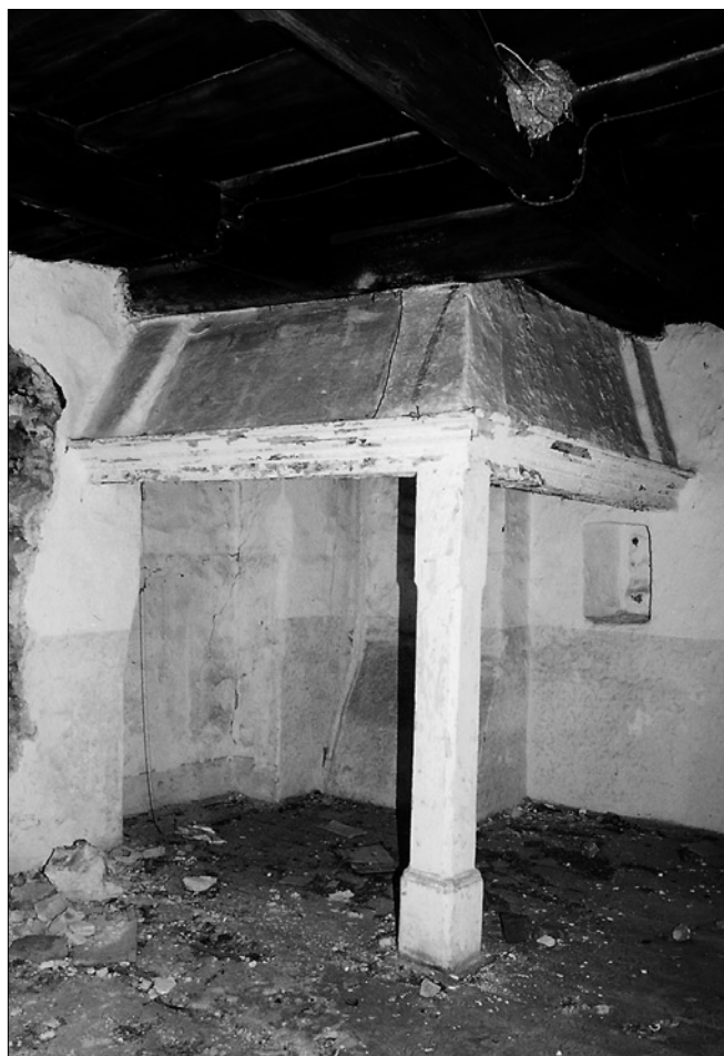
Obr. 1: Brandýs nad Labem čp. 153 (okr. Praha - východ), kuchyně horního jižního bytu s ústím dymníku, vynášeným úhlovou sestavou římsových trámů se sloupkovou podporou. Pod dymníkem vlevo byla nika pro obsluhu kamen ve světnici, v koutu rizalit sopouchu pro dým kuchyně z přizemí. Stav 1995.
