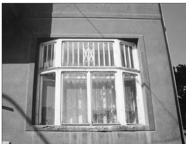
Obr. 20: Jaruškův dům v Brně - Králově Poli, původní krystalické okno v pravé krajní ose v přízemí (foto D. Černoušková, 1996).
