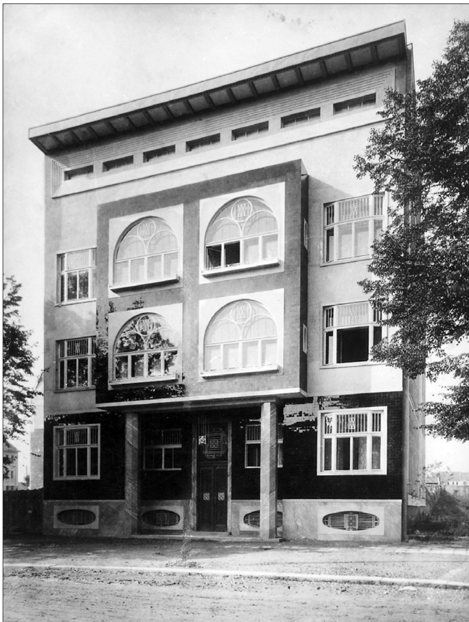
Obr. 1: Jaruškův dům v Brně - Králově Poli, uliční průčelí, pohled od severozápadu (NTM Praha, oddělení architektury a stavitelství, pozůstalost arch. Gočára, sign. f 14 - uložení 24 a/c).
