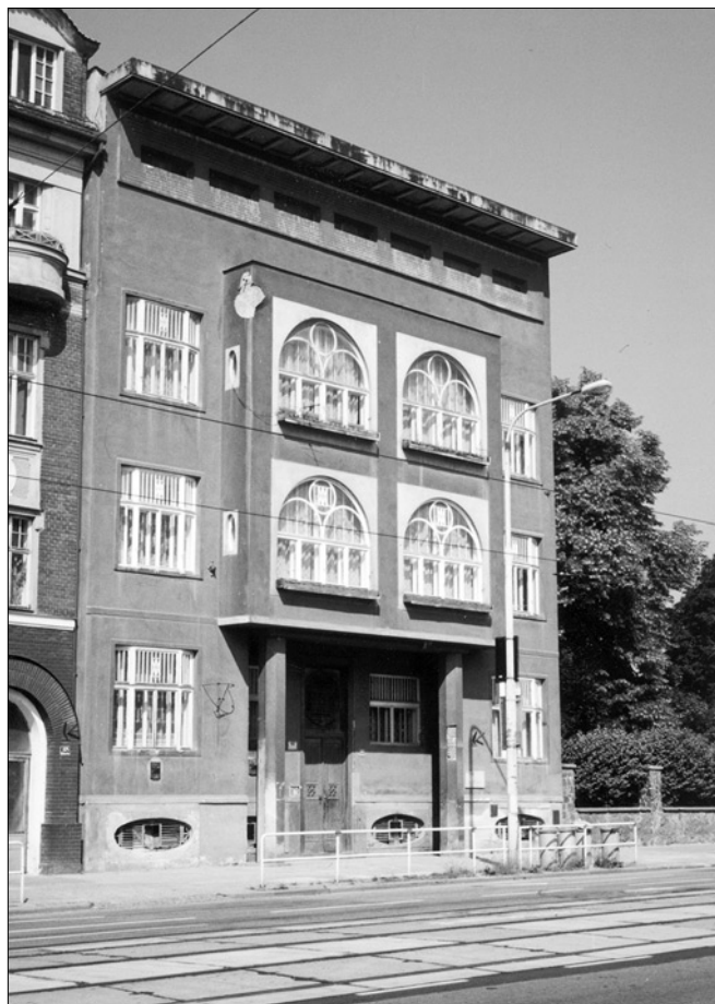
Obr. 2: Jaruškův dům v Brně - Králově Polí, uliční průčelí, pohled od jihozápadu (foto D. Černoušková, 1996).
