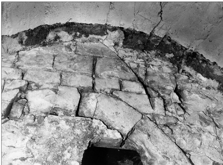
Obr. 4: Praha 1 - Staré Město, čp. 459/I. Detail části klenebního čela s patrným obloukem hrany pro osazení bednění nad ostěním románského vstupního portálu (foto F. Malý, 1998).
