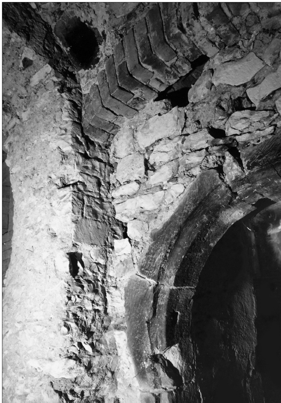
Obr. 6: Praha 1 - Staré Město, čp. 147/I. Zbytek vnitřního líce jižní zdi někdejší vstupní šíje, pokračující za do- datečně opřenou stěnu s půlkruhově ukončeným gotickým pískovcovým portálem. K tomuto portálu náleží i cih- lový záklenek, zapuštěný nahore do kvádříkové líce románského zdiva (foto F. Malý, 1998).
