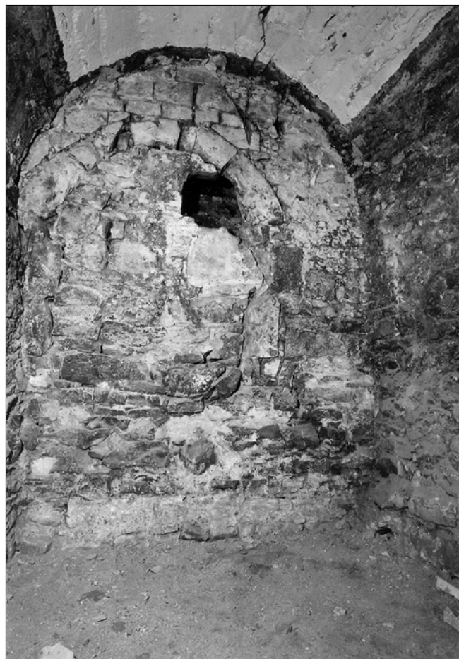
Obr. 3: Praha 1 - Staré Město, čp. 459/I - vnější líc jižní stěny románského domu v pohledu ze sklepu domu čp. 460/I. V partii vymezené mladší valenou klenbou je patrný zbytek ostění půlkruhově ukončeného románského vstupního portálu (foto F. Malý, 1998).
