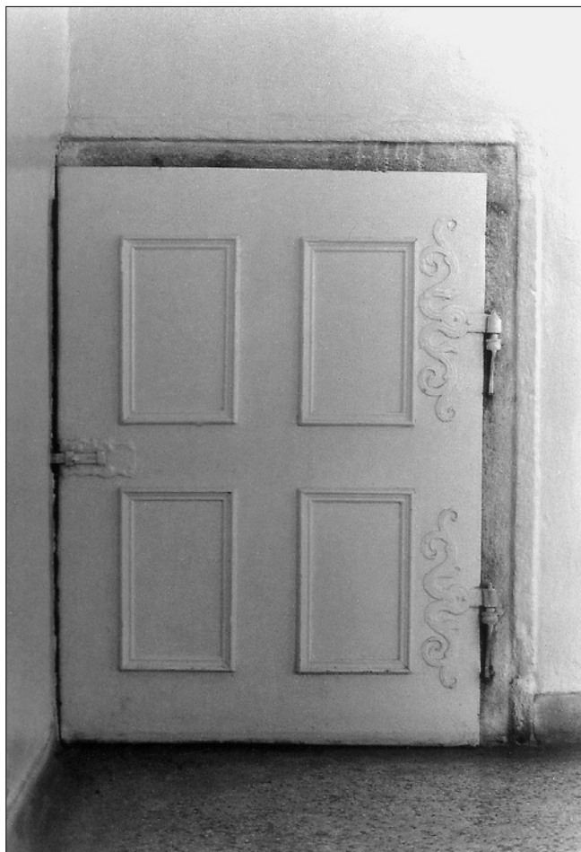
Obr. 22: Pohled, komínová dvířka v chodbě 1. patra západního křídla klášterního konventu (foto J. Svobodová, 1995).
