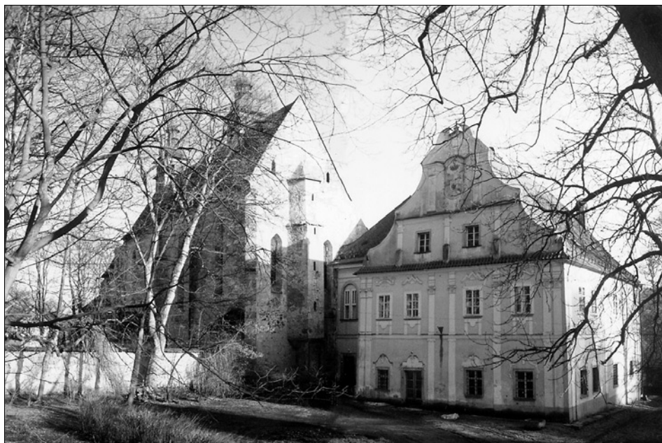
Obr. 2: Pohled, kostel sv. Ondřeje a stará prelatura. Pohled od severozápadu (foto L. Svoboda 1997).
