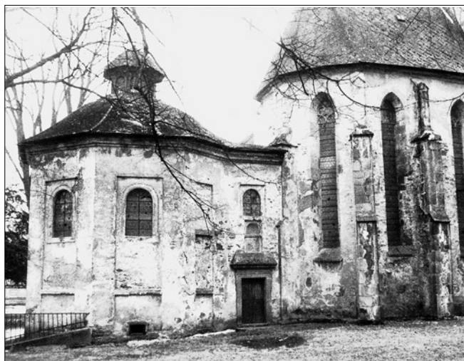
Obr. 14: Pohled, kaple Všech svatých od severu (foto L. Svoboda, 1983).
