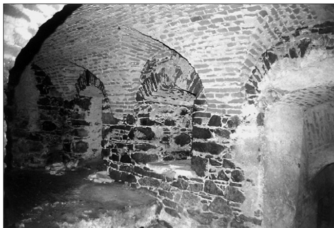
Obr. 7: Pohled, sklepní podesta hlavního schodiště klášterního konventu s výklenky středověkých okének (foto L. Svoboda 1997).
