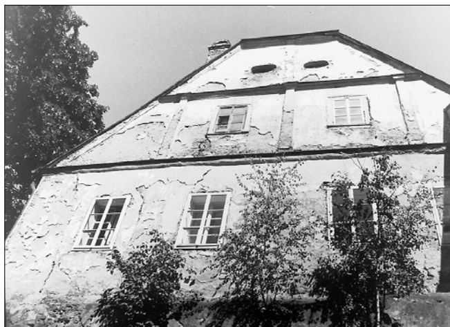
Obr. 9: Pohled, jižní průčelí staré prelatury s renesančním štítem a zazdívkami arkád (foto L. Svoboda 1983).
