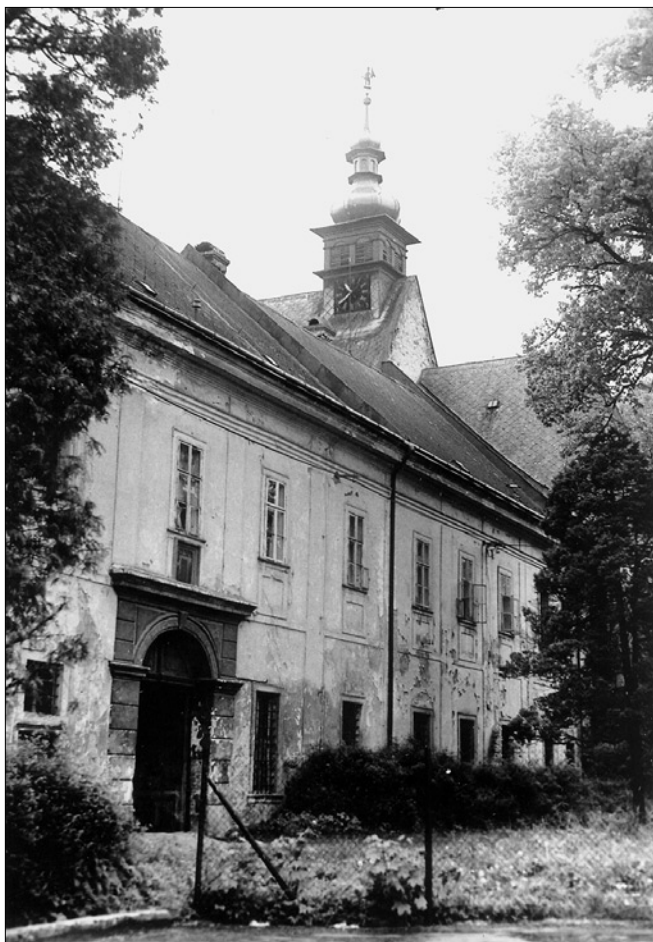
Obr. 12: Pohled, východní průčelí klášterního konventu (foto L. Svoboda)
