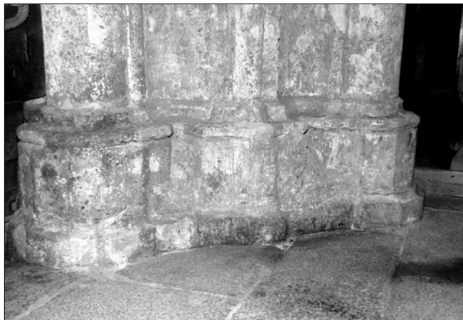
Obr. 7: Neuberg, klášterní kostel, patka pilíře.
