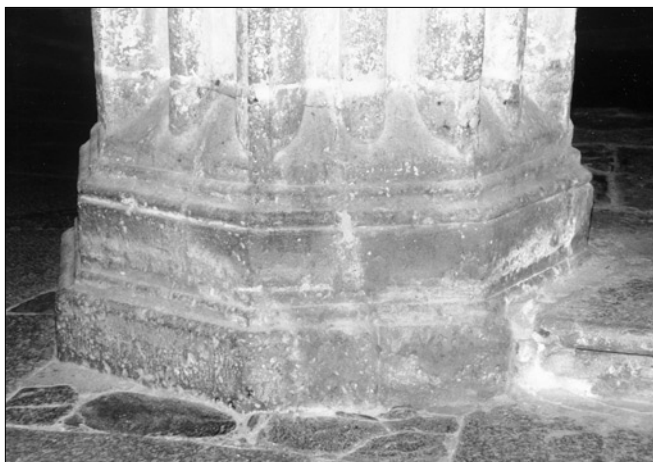
Obr. 27: Pöllauberg, poutní kostel, patka pilíře v interiéru.
