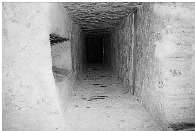
Obr. 6: Hrad Lockenhaus (Burgenland, Rakousko). Vnitřek horní části záchodového rizalitu - pohled vzhůru (foto J. Škabrada, 1998).
