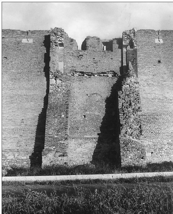
Obr. 6: Lucera, destruovaná věž anjouovského městského opevnění (foto J. Varhaník, 1995).
