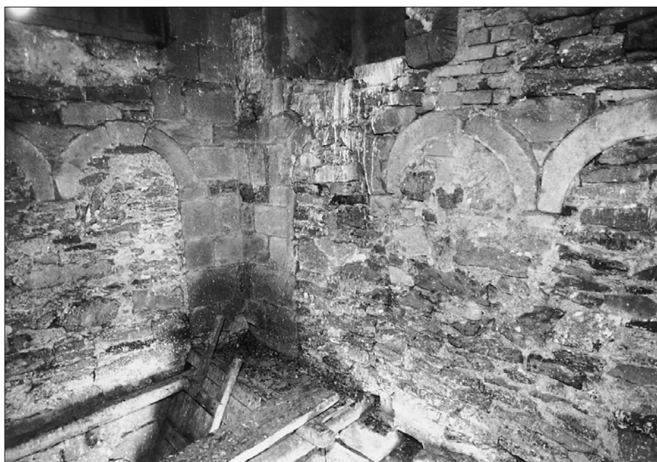
Obr. 5: Ředhošť, kostel sv. Jiljí. Jihovýchodní kout třetího patra věže s viditelnými obrysy zazděných sdružených okének střední galerie (foto Jan Sommer, 1998).
