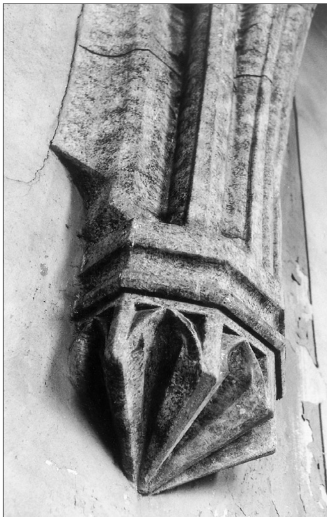
Obr. 7: Ředhošť, kostel sv. Jiljí. Klenební konzola na severní straně presbyteria (foto Jan Sommer, 1998).
