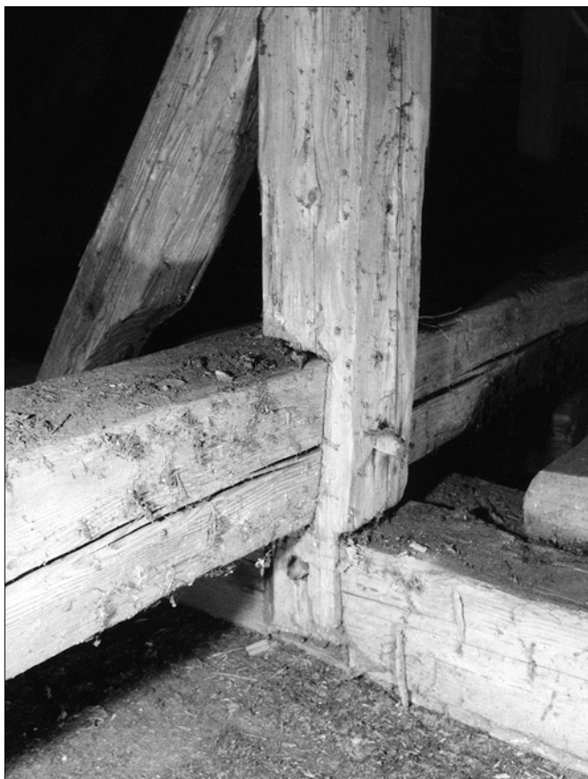
Obr. 25: Kostel sv. Vojtěcha - krov lodi, detail prahové vaznice (foto Petr Růžička, 1997).
