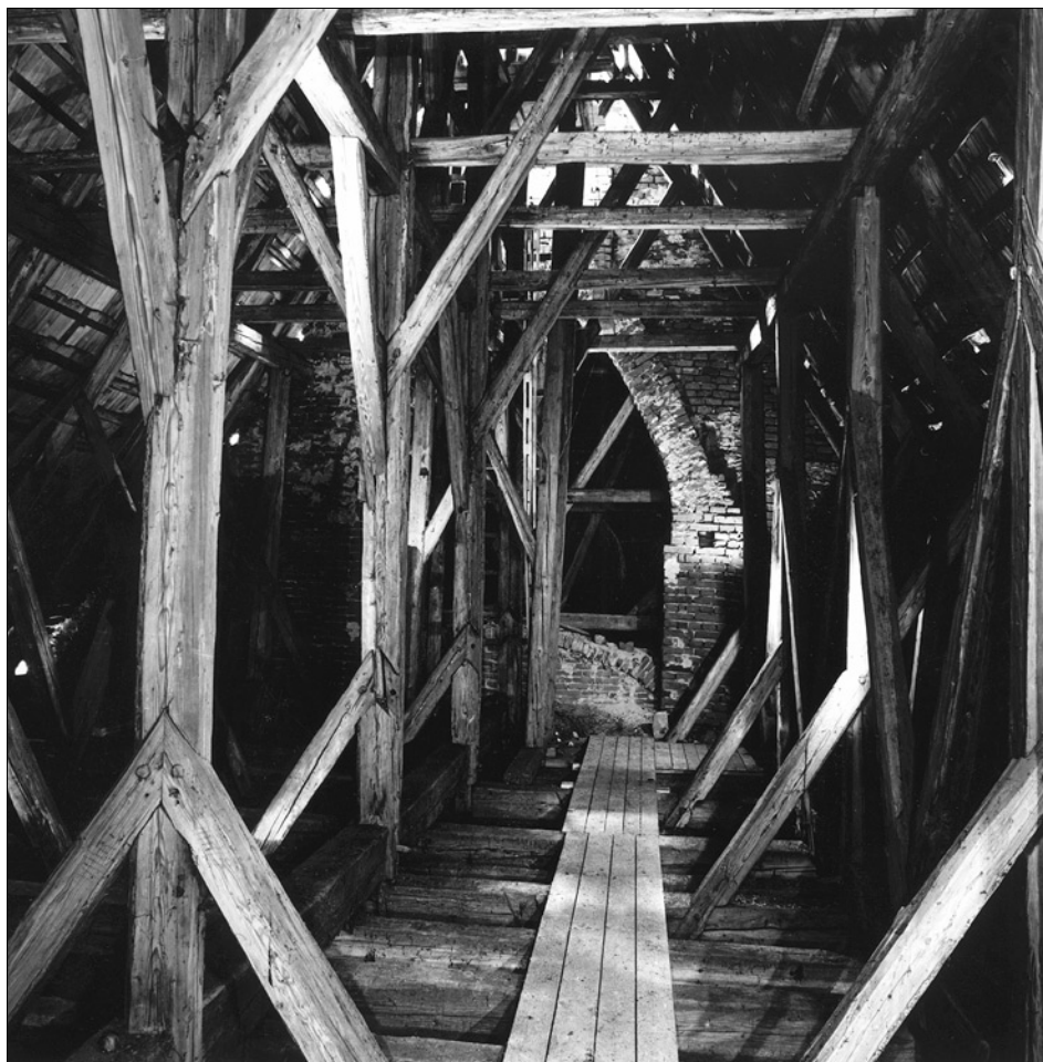
Obr. 17: Kostel sv. Vojtěcha - pohled do krovu nad hlavní lodí (foto Antonín Bína, 1998).
