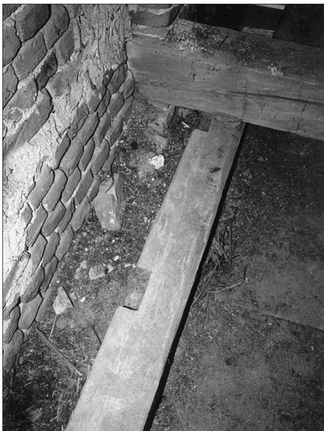
Obr. 26: Kostel sv. Vojtěcha - krov lodi, detail vazného trámu 11 vazby (foto Antonín Bina, 1998).
