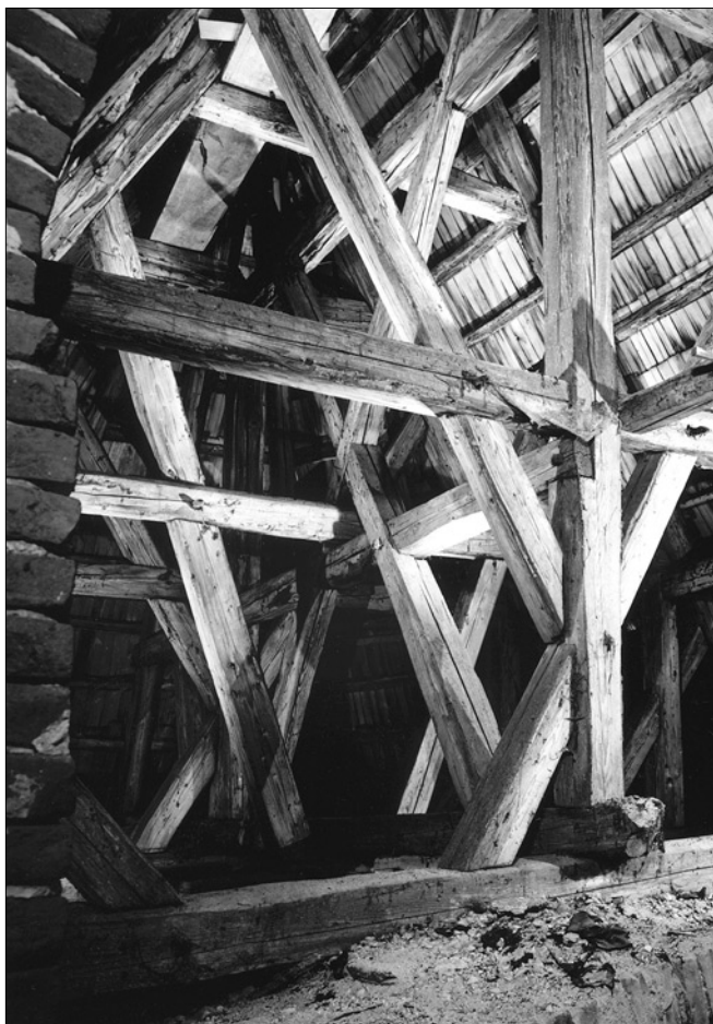
Obr. 21: Kostel sv. Vojtěcha - pohled do krovu nad presbyteriem (foto Antonín Bína, 1998).
