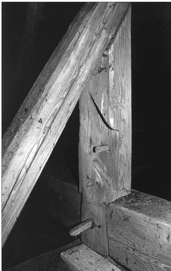
Obr. 27: Kostel sv. Vojtěcha - krov lodi, detail západního sloupku jižní postranní stolice (foto Antonín Bina, 1998).
