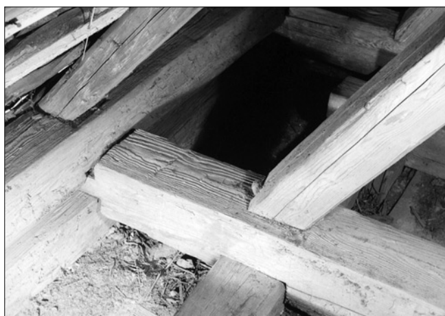
Obr. 20: Kostel sv. Vojtěcha - krov nad lodí, detail uložení do pozednicového věnce (foto Petr Růžička, 1997).
