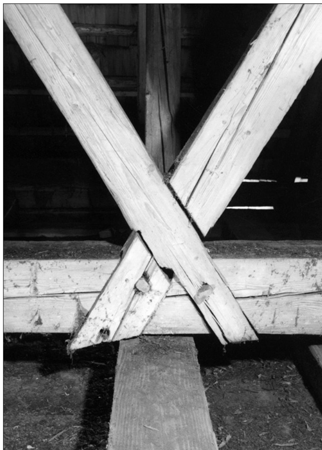
Obr. 19: Kostel sv. Vojtěcha - krov nad lodí, detail vzpěr jižní laterální stolice (foto Petr Růžička, 1997).
