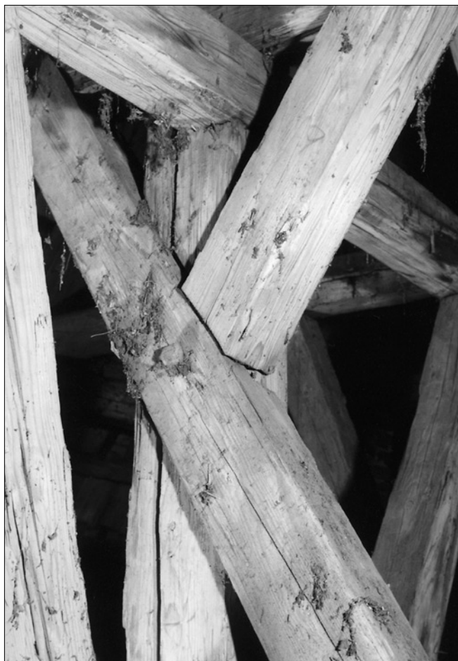
Obr. 22: Kostel sv. Vojtěcha - krov nad presbyteriem, detail průčné vazby (foto Petr Růžička, 1997).
