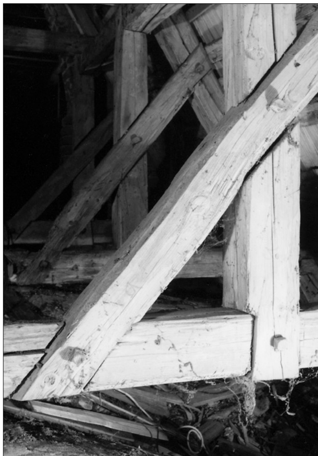
Obr. 23: Kostel sv. Vojtěcha - krov nad presbyteriem, detail laterální stolice podélného vázaní (foto Petr Růžička, 1997).
