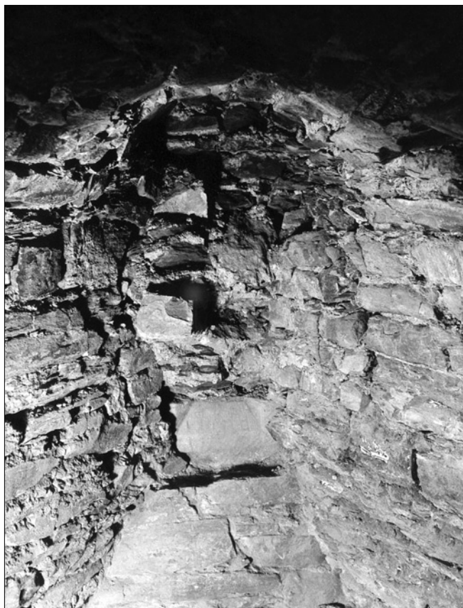
Obr. 9: Zazděné okno, odkryté v roce 1973 pod podlahou ve středu jižní stěny kostela sv. Mikuláše v Jaroměři. V blízkosti oltáře sv. Mari Magdaleny, pohled od severu. Patrný oboustraně zešíkmený parapet s ústupkem (foto Václav Novák, 1973).
