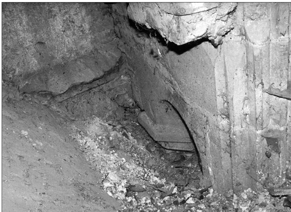
Obr. 19: Severozápadní kout podkrovní jižní lodi. Vpravo zdivo mezilodní arkády a cihelný pilířek, dodatečně nasazený ke klenebnímu výběhu. V pozadí kamenné zdivo věže s římsou (foto Jiří Slavík, 1998).
