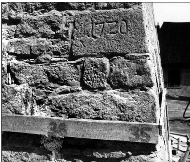
Obr. 8: Kámen s letopočtem 1720, vsazený do jihozápadního nároží opěráku při jihovýchodním nároží kostela sv. Mikuláše a dnes zakrytý cementovou omítkou, pohled od západu (foto Václav Novák, 1973), (viz obr. 11).
