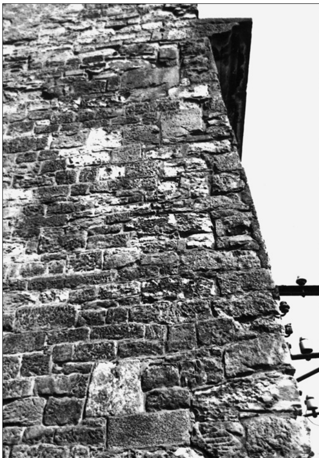
Obr. 7: Kvádríkové zdivo v západním lici opěráku při jihovýchodním nároží kostela sv. Mikuláše, pohled od západu (foto Jiří Slavík, 1998).
