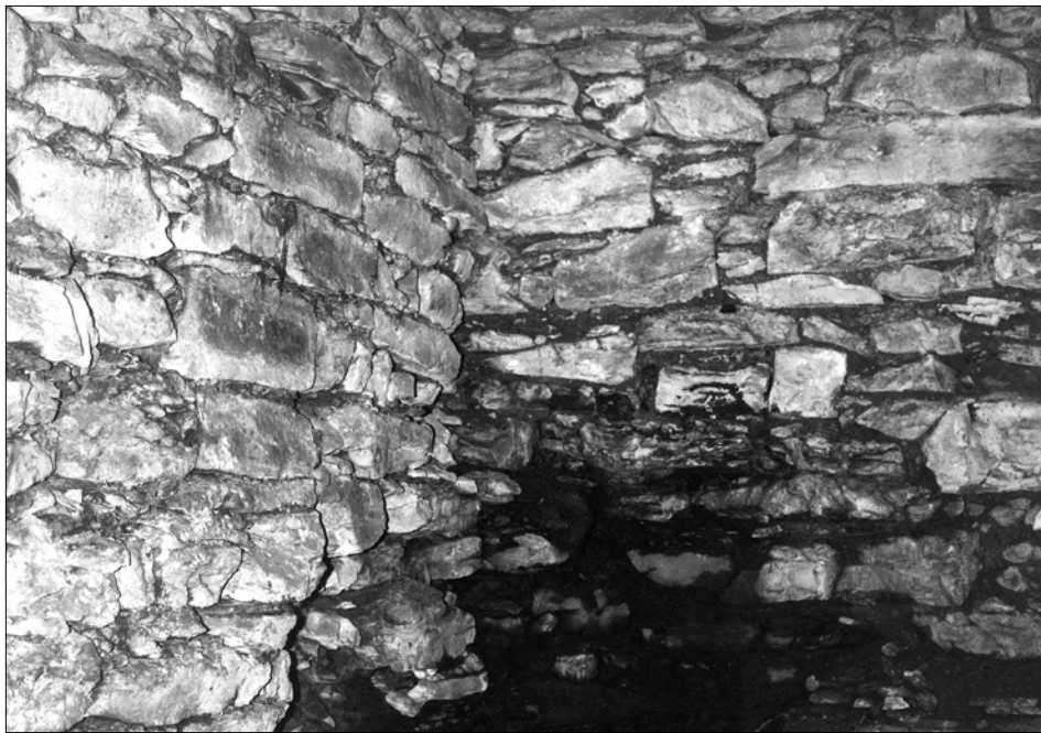
Obr. 13: Severozápadní kout interiéru věže při jihozápadním nároží kostela sv. Mikuláše, pohled od jihu. Nejnížší podlaží věže, v dolní části vystupuje skalní podloží (foto Václav Novák, 1998).
