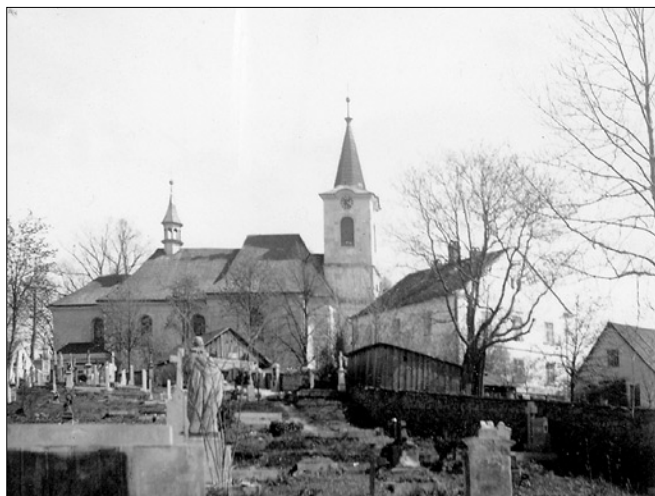
Obr. 6: Nový Hrádek (okr. Náchod), kostel sv. Petra a Pavla (fotografie z roku 1949).
