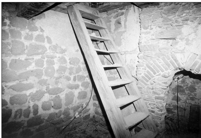
Obr. 6: Kostel sv. Prokopa v Lestkově. První patro věže, zdivo presbytáře románského kostela sestavené z nepravdělně opracovaných kvádrů.
