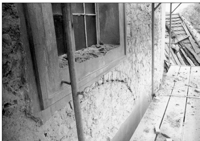
Obr. 10: Všeradice, kostel sv. Bartoloměje, detail pasu, kterým se loď otevírala do jižní kaple (všechna foto autor 1996 - 99).
