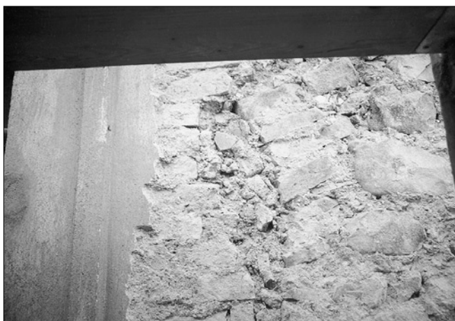
Obr. 6: Všeradice, kostel sv. Bartoloměje, detail fragmentu odkrytého gotického okna na jihu lodi.
