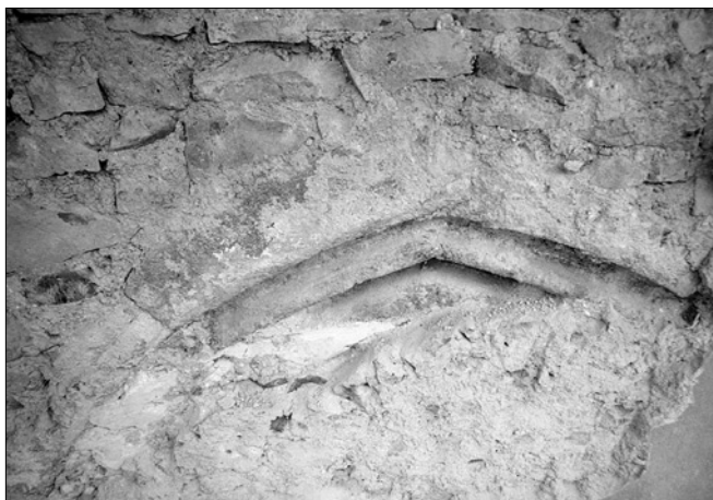
Obr. 5: Všeradice, kostel sv. Bartoloměje, detail archivoly gotického portálu se zbytky interiérové omítky mladší předsíně.
