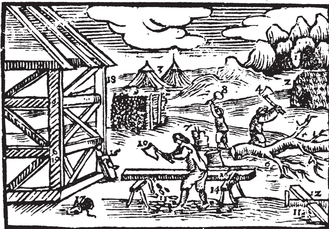
Obr. 1: Výroba trámů pro stavbu krovu ve 2. pol. 17. stol. Jan Amos Komenský v Orbis Sensualium Pictus, 1685.
