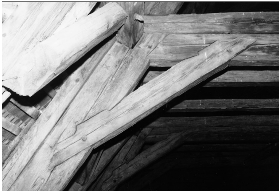
Obr. 11: Krov kostela Jména Ježíš v Telči: detail pásky příčné plné vazby stolice (foto Antonín Bína, 1997).
