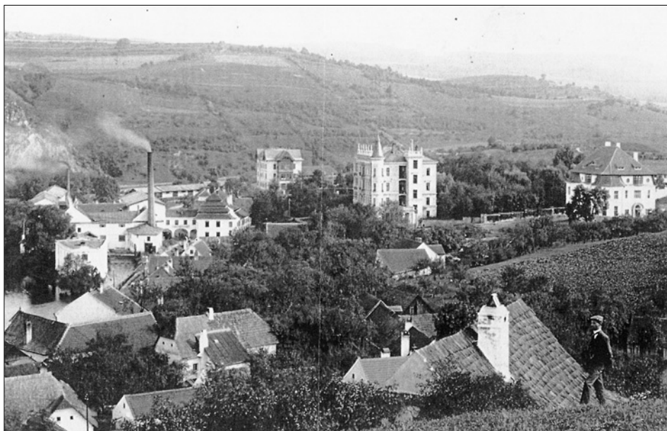
Obr. 15: Anonym, Plešivec se spirovským obytným (čp. 268, 275, 279) a průmyslovým areálem, kolem r. 1908 (foto Státní okresní archiv Č. Krumlov).
