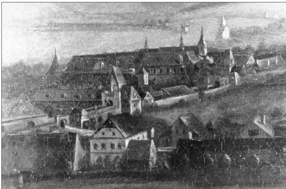
Obr. 32: Veduta Českého Krumlova od G. A. Hörnera, kolem r. 1750, pohled od severozápadu (SZ Č. Krumlov). Detail se systémem Budějovické brány v popředí, upravo od ní zeď spojovacího koridoru na bývalé rybníční hrázi, zakončená vnější Latránskou bránou s předbraním. Vlevo od této brány část novoměstské hradební zdi s hranolovou věžovou stavbou u nároží kvadratury klarisek a zcela vlevo oblá nárožní bašta (foto L. Pouzar).
