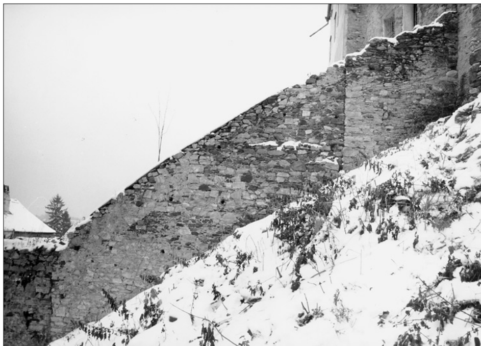
Obr. 26: Český Krumlov. Jižní část vnějšího, západního líce hradební zdi mezi severním průčelím Horního hradu (vpravo) a nárožním domem čp. 64. Vpravo parkánová zeď s původním nárožím a zazděnou střelnu, uprostřed úsek středověké zdi, jejíž dolní nároží není původní, zcela vlevo část zdi tzv. bastionu (foto autor, 1997).
