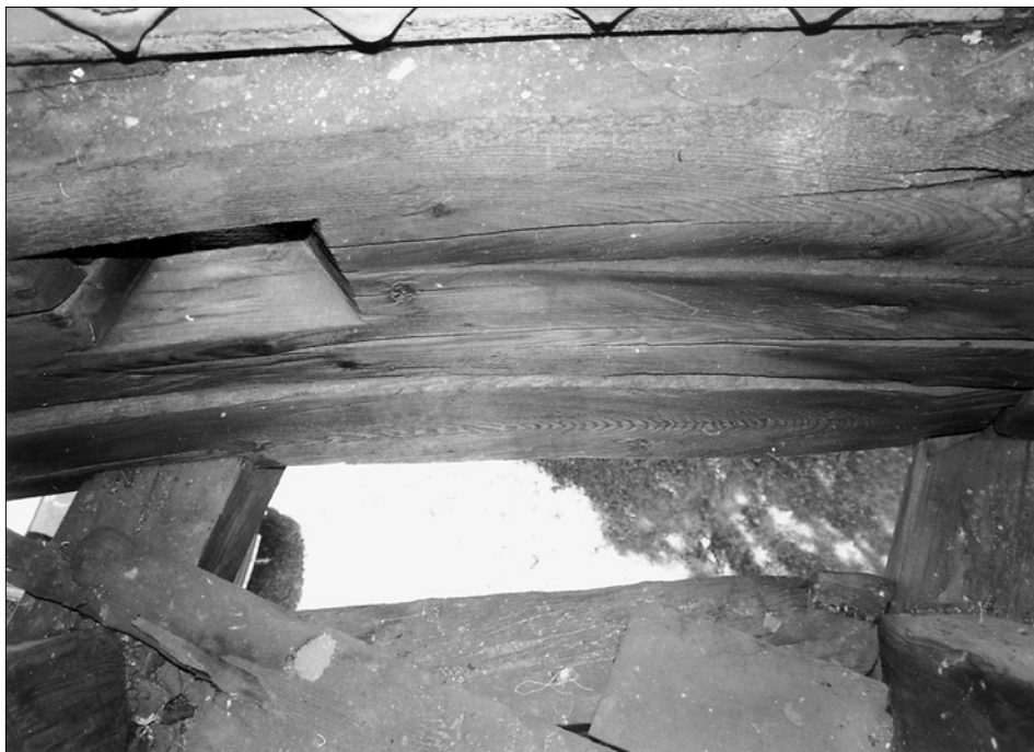
Obr. 21: Český Krumlov. Novoměstská nárožní bašta, čp. 28. Podstřeší, detail roubeného věnce se střílnou a mezerou podsebití (foto autor, 1996).
