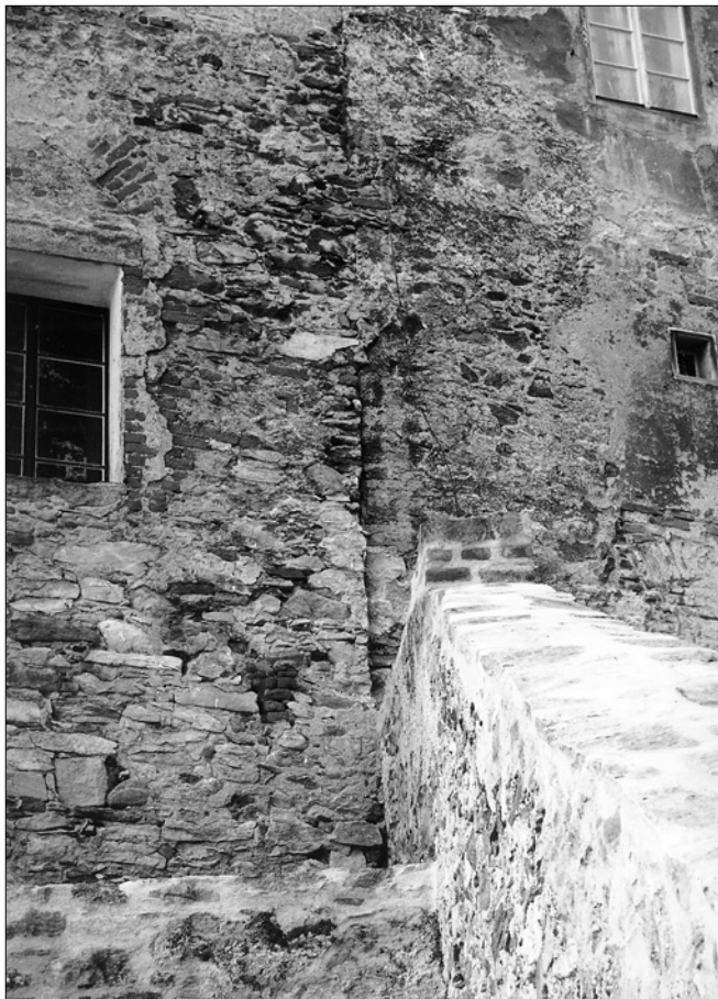
Obr. 28: Český Krumlov. Pohled na severní průčelí Horního hradu. Detail návaznosti bývalé parkánové zdi (koruna po rekonstrukci, srov. obr. 26 a 27). Na průčelí hradu otisk zaniklé horní části zdi s pultovou stříškou. Průčelí vlevo od tohoto otisku bylo druhotně na spáru přistavěné k parkánové zdi (foto autor, 1999).
