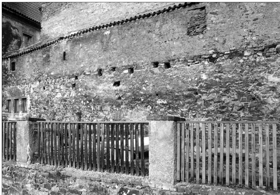
Obr. 7: Český Krumlov. Vnější líc hradební zdi Latránu za domy čp. 16 - 20. V horní části upravené střelny (foto autor, 1998).
