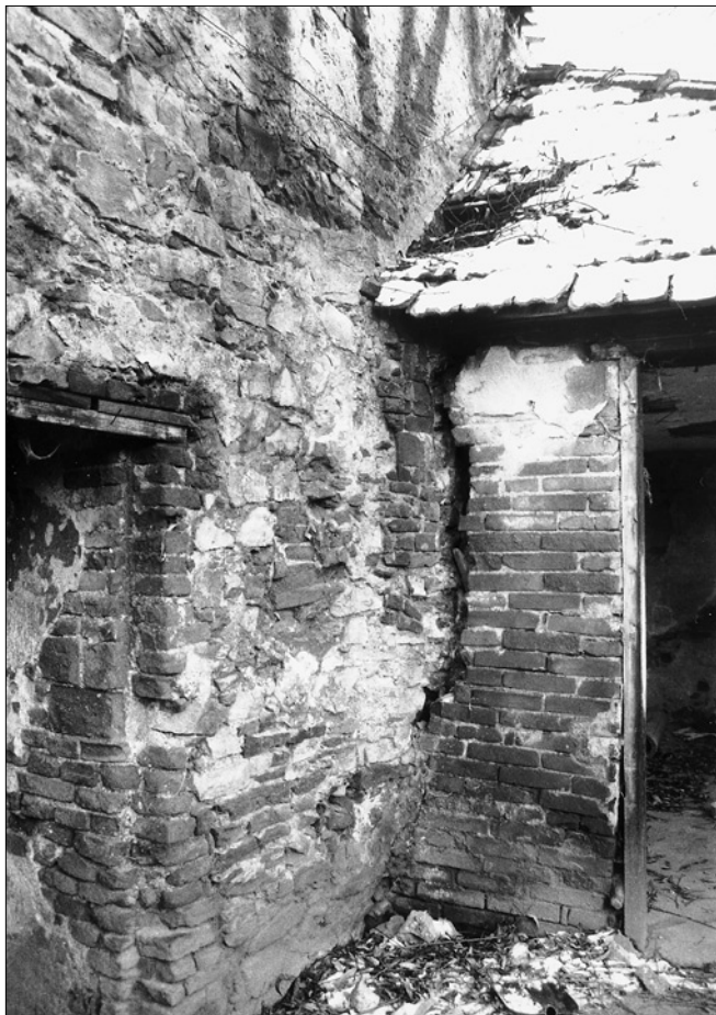
Obr. 8: Český Krumlov. Vnější líc hradební zdi Latránu za domem čp. 20. Altán (vpravo) přiléhá v místech půdorysného vybočení zdi, horní část (předprvní zeď ochozu) však probíhá v přímce (foto autor, 1995).
