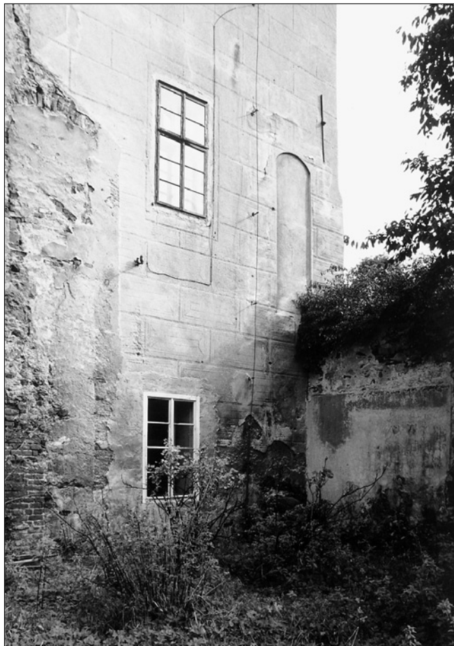
Obr. 9: Český Krumlov. Styk vnitřního líce hradební zdi Nového Města (vpravo) s jižním nárožím panského pivovaru, čp. 27. Na průčelí zazděný vstup z domu na zaniklý hradební ochoz (foto autor, 1999).
