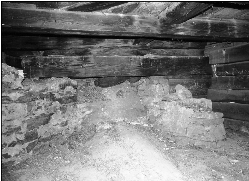
Obr. 15: Český Krumlov. Novoměstská nárožní bašta, čp. 28. Interiér horního polopatra, detail styku středověkého obvodového zdiva (neomítnutý líc vlevo) s dodatečnou uzavírací zdí na městské straně. Vpravo ukončení pláště točitého schodiště a trámová přička, vymezující vyústění schodiště do tohoto podlaží. Pod roštovou stropní konstrukcí druhotně vložený mohutný trám, do něhož je osazen horní konec vřetena schodiště. Schodiště vpravo za trámovou přičkou (foto autor, 1996).
