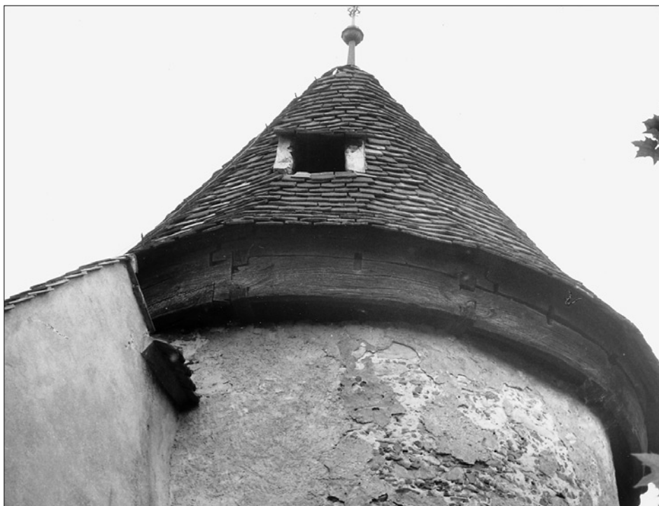
Obr. 39: Roubené podstřešní patro bašty opevnění kláštera benediktinek v Göss u Leobenu (foto autor, 1999).
