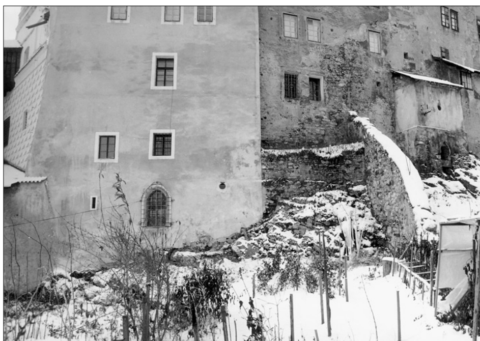
Obr. 27: Český Krumlov. Pohled z prostoru tzv. bastionu na severní průčelí hradu. Vpravo Horní hrad, z jehož průčelí směřek k severu vybíhá hradební zeď (srov. obr. 26). Její horní díl (parkánová zeď hradu) se lomí k východu (uprostřed snímku) a přechází do spodní části severní obvodové zdi přístavby tzv. Máselnice - omítnuté průčelí vlevo (foto autor, 1997).
