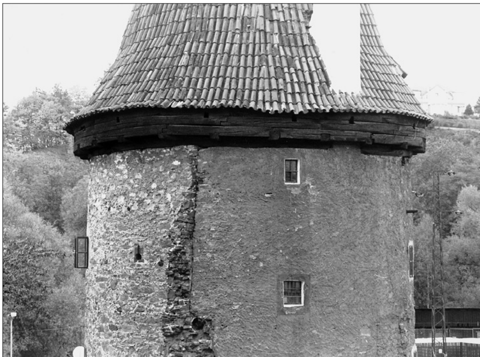
Obr. 16: Český Krumlov. Novoměstská nárožní bašta, čp. 28. Detail s roubeným podstřešním patrem (foto autor, 1999).
