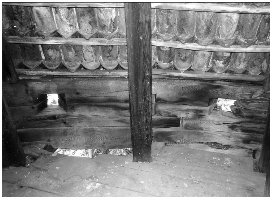
Obr. 18: Český Krumlov. Novoměstská nárožní bašta, čp. 28. Podstreší, detail roubeného věnce se dvěma střílnami (foto autor, 1996).
