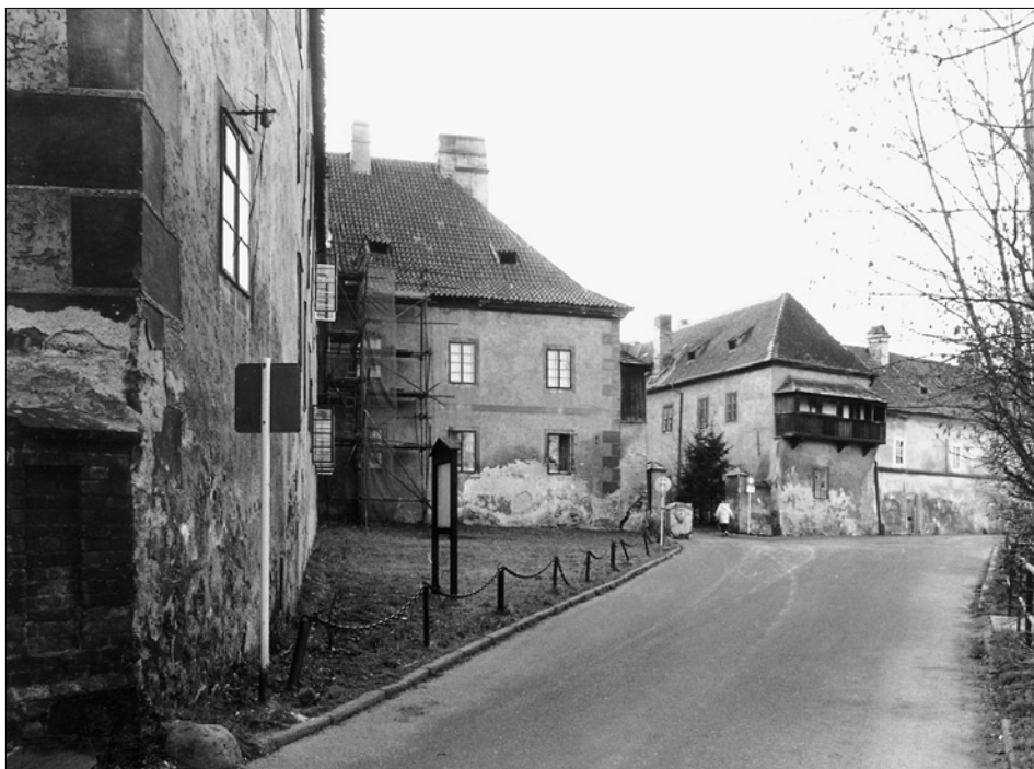
Obr. 24: Český Krumlov. Zkosené severní průčelí kvadratury kláštera klarisek (vlevo), východní průčelí severozápadního, barokního křídla klarisek (uprostřed) a domy čp. 141 a 78 (vpravo), v jejichž průčelích je dochována novoměstská hradební zeď. Pohled od východu (foto autor, 1997).
