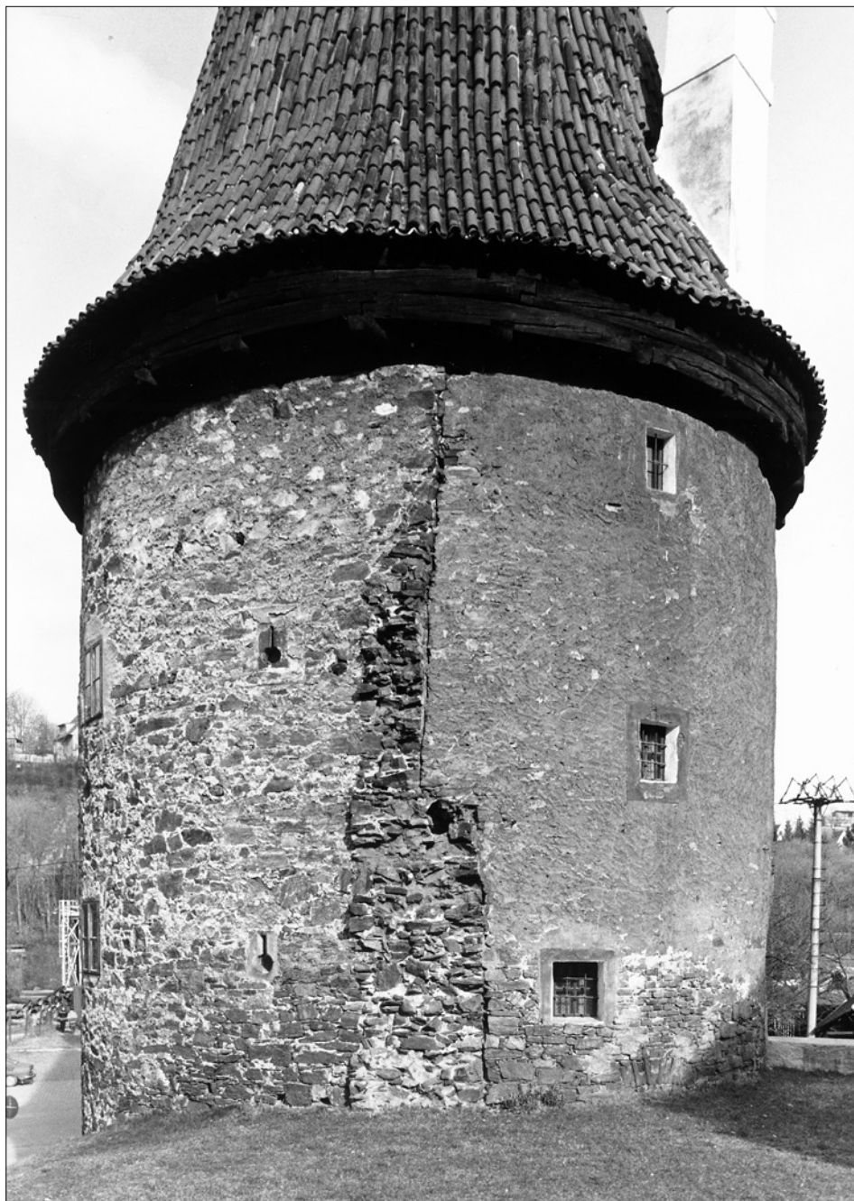
Obr. 14: Český Krumlov. Novoměstská nárožní bašta, čp. 28. Pohled od západu. Vlevo původní část obvodového zdiva s klíčovými střílnami v 1. a 2. patře, vpravo dodatečná část, která uzavřela baštu na městské straně. Uprostřed svislý řez odbouranou hradební kurtinou s odskokem ochozu, vysokou předprsní zídskou a otiskem příkré pultové stříšky (foto autor, 1998).
