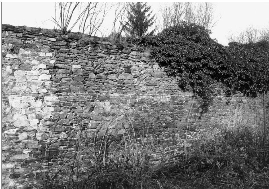
Obr. 10: Český Krumlov. Vnější líc hradební zdi Nového Města jihozápadně od čp. 27 (panský pivovar). Středověké zdivo, vystavěné ze dvou odlišných hornin, je místy nahrazeno pozdějšími konstrukcemi - vlevo (foto autor, 1997).
