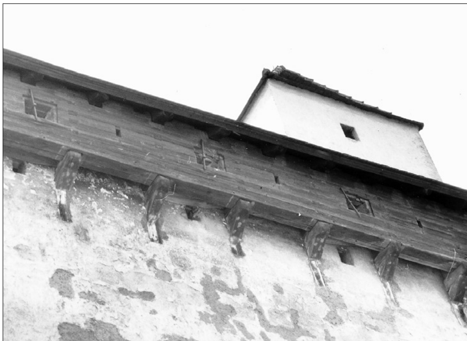
Obr. 38: Roubená předprseň ochozu s podsebitím štítové zdi jádra hradu Burghausenu, srov. obr. 36 nahoře (foto autor, 1997).
