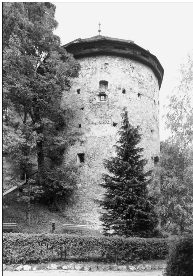
Obr. 37: Severovýchodní nárožní bašta opevnění města Radstadt nad řekou Enns, dat. 1534. Roubené podstřešní patro se střílnami s trojicí zářezů v parapetu (foto autor, 1999).
