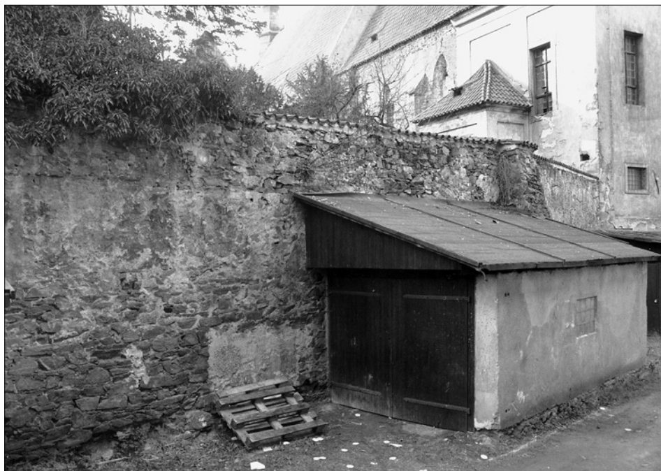
Obr. 33: Český Krumlov. Vnější líc ohradní zdi klášterního areálu za pivovarskou restaurací. V popředí předpokládaná středověká zeď, za opěrným pilířem upravo patrně barokní úsek v pozměněném směru. Tento úsek v pozadí přiléhá k nároží barokního prodloužení presbytáře klášterního kostela (foto autor, 1997).
