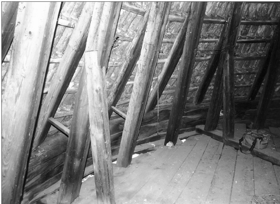
Obr. 20: Český Krumlov. Novoměstská nárožní bašta, čp. 28. Podstřeší, spodní část krovu s roubeným věncem (foto autor, 1996).
