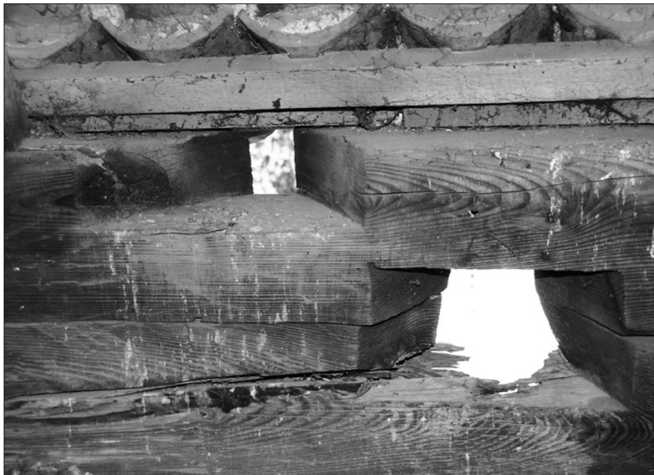
Obr. 22: Český Krumlov. Novoměstská nárožní bašta, čp. 28. Podstřeší, detail roubeného věnce s ojedinelou dvojicí střílen (foto autor, 1996).
