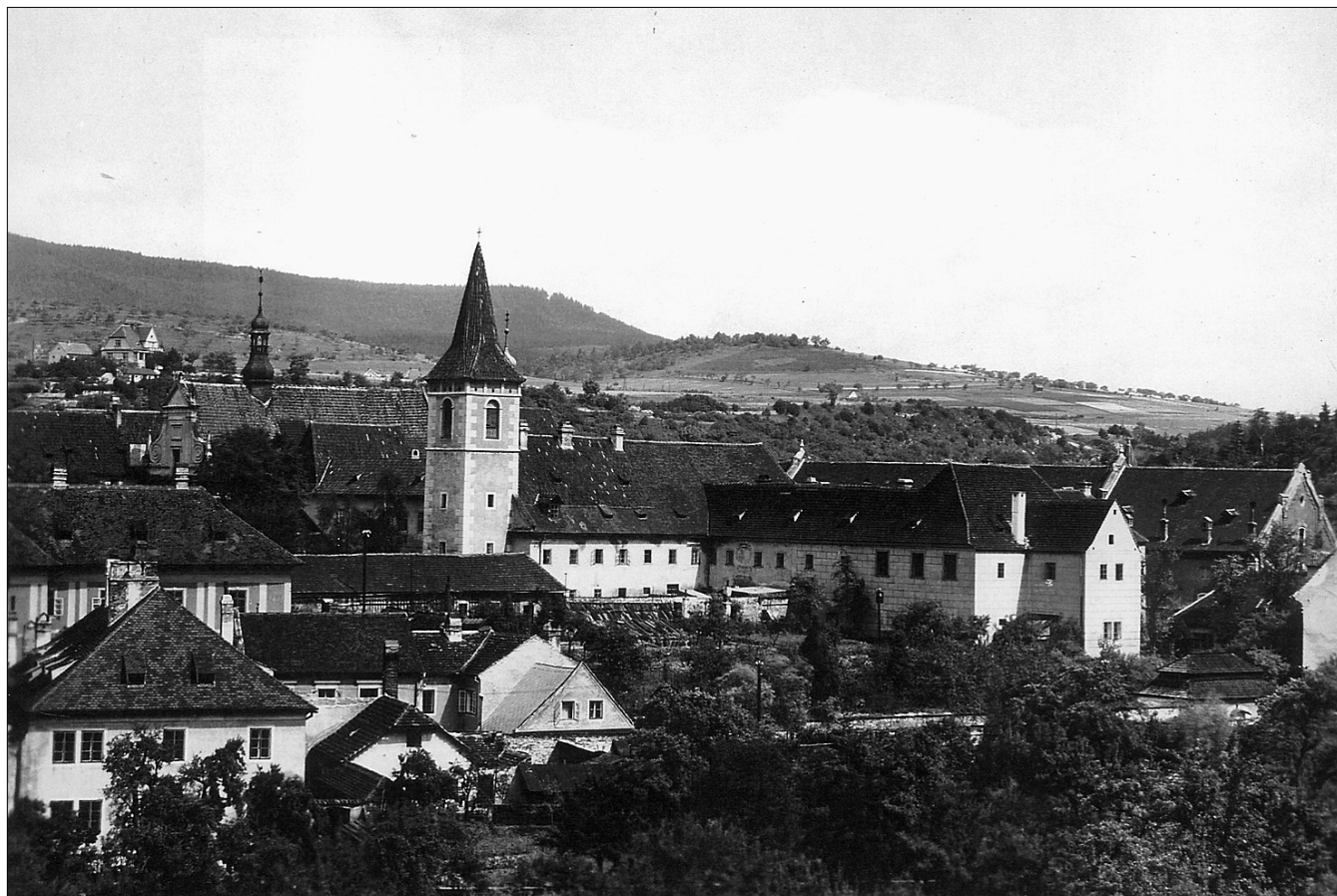
Obr. 2: Český Krumlov, pohled na klášter od jihozápadu, stav v roce 1946 (foto SÚPPOP, J. Tuháček).
