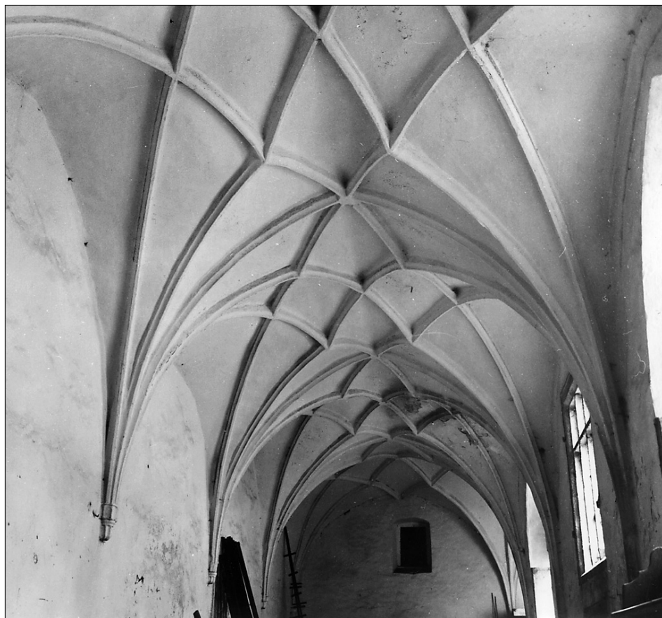
Obr. 24: Český Krumlov, konvent menších bratří, sítová klenba jižního ramene ambitu, kolem 1490, stav v roce 1995 (foto H. Soukupová).
