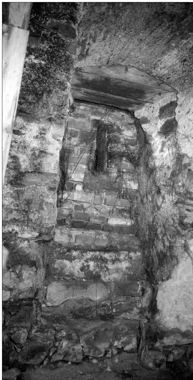
Obr. 13: Český Krumlov, konvent klarisek, branka k řece ve sklepech v severním křídle, kolem 1360 - 1380, stav v roce 1999 (foto H. Soukupová).
