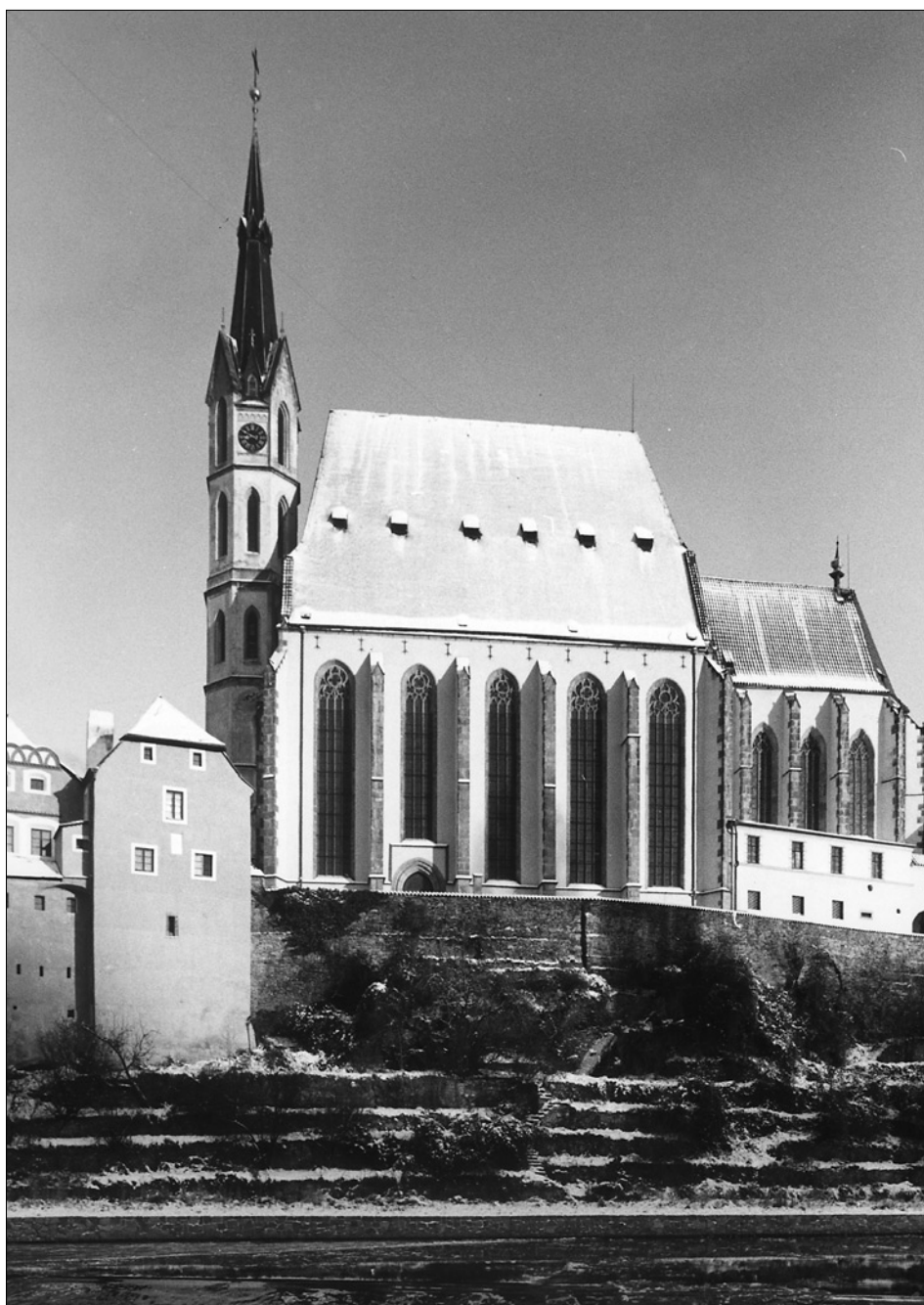
Obr. 2: Český Krumlov, kostel sv. Víta, celkový pohled od jihu (foto V. Razím, 1999).
