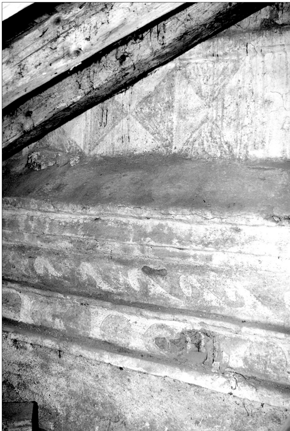
Obr. 4: Český Krumlov, zbytky původního sgrafita na východní zdi Máselnice, chráněné střešní konstrukcí sousední budovy, detail (foto L. Pouzar).
